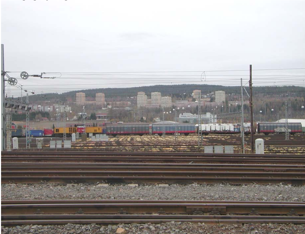
Alnabru terminal (Kilde: Jernbaneverket)
