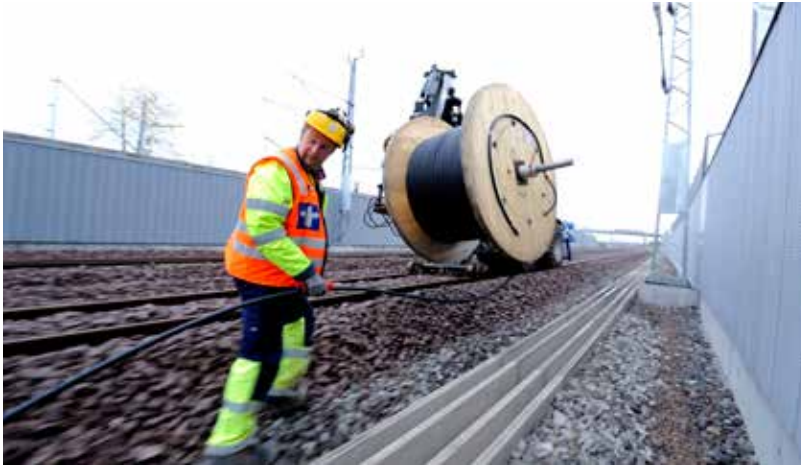
Det legges signalkabel mellom Barkåker og Tønsberg. Foto: Øystein Grue
