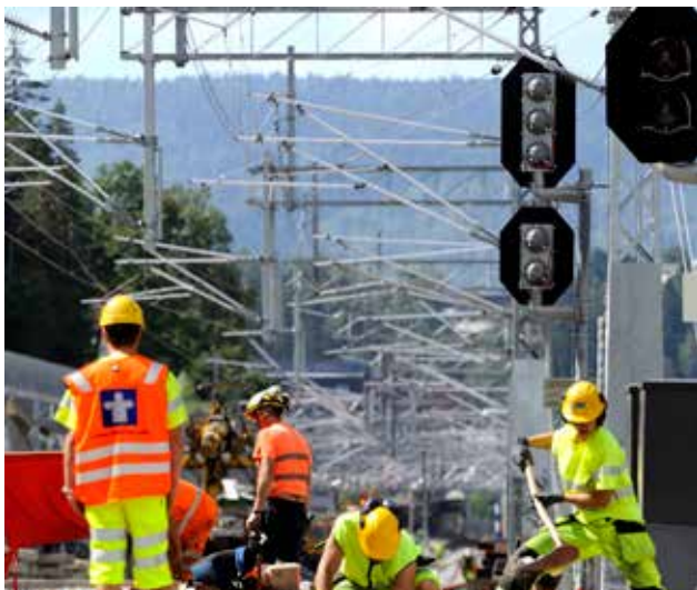
Bygging av dobbeltspor ved Sandvika. Foto: Øystein Grue
