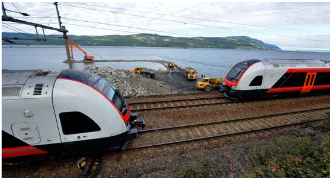
Tog krysser ved Strandlykkja under bygging av dobbeltsporet mellom Langset og Kleverud. Dette var første trinn i utbyggingen til dobbeltspor mellom Eidsvoll og Hamar.
