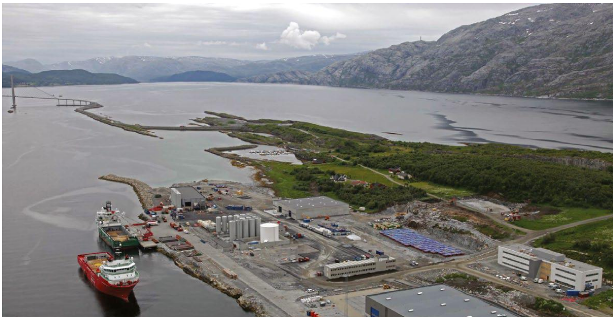
Helgelandsbasen, Sandnessjøen. Forsyningsbasen og bedriftsetableringer vil vokse med petroleumsutbyggingen utenfor Helgelandskysten (Foto: BP-Norge).
