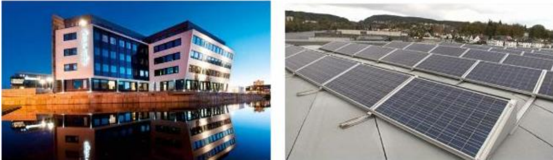
Figur 15 - Agder Energi sitt solcelleanlegg på deres kontorbygg i Kristiansand 37
