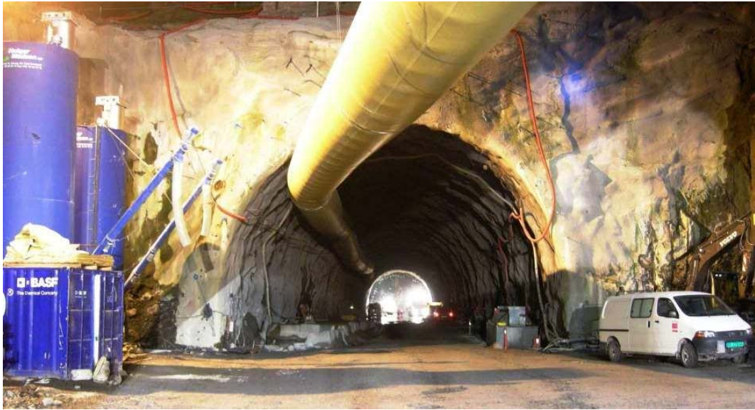
Figur 7: Siloer til injeksjonssement, ventilasjonskanal og påhugg. Bærumstunnelen Lysaker Vest
