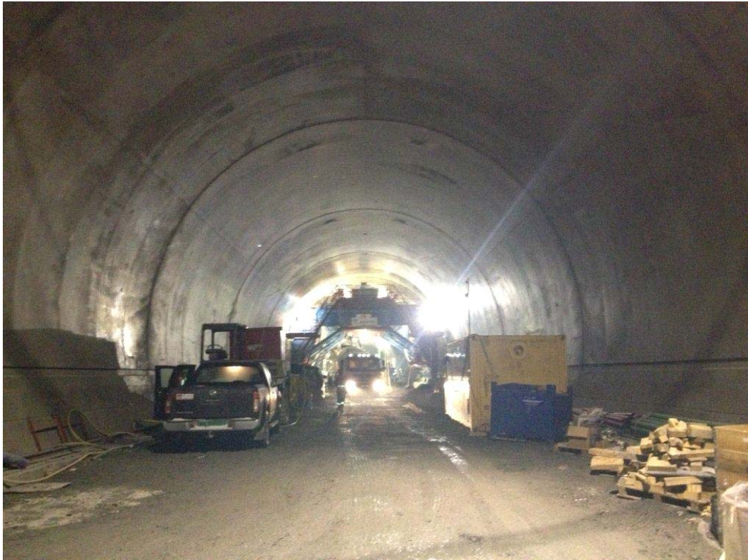
Figur 13: Ferdig kontaktstøpt betonghvelv i Ulvintunnelen. Fellesprosjektet E6-Dovrebanen
