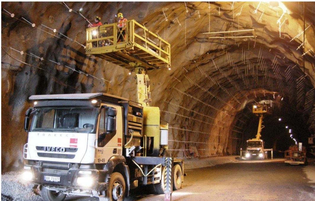
Figur 14: Montasje av bolter for PE hvelv i Bærumstunnelen
