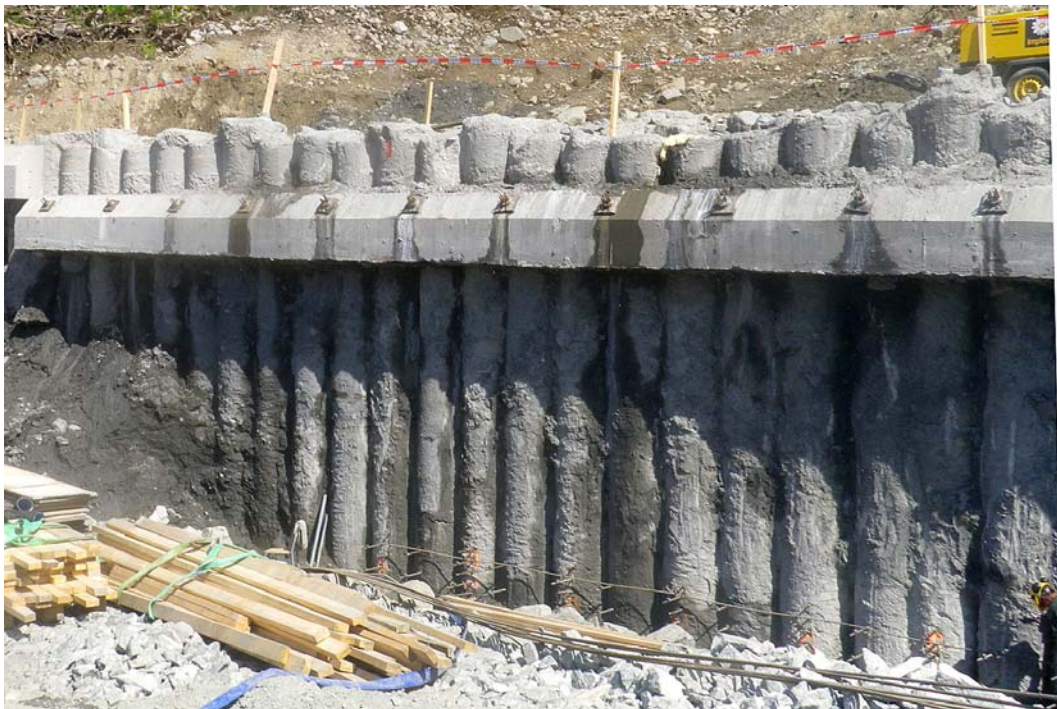
Figur 34: Sekantpelevegg på Fellesprosjektet langs Mjøsa (Foto: JBV)
