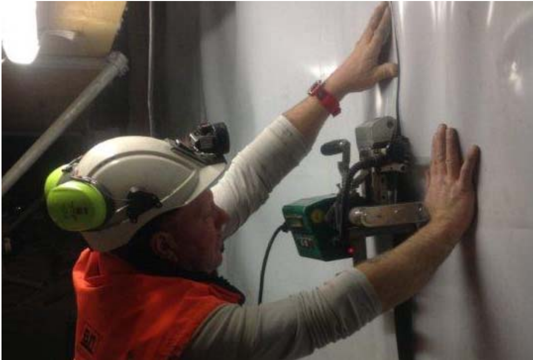
Figur 11: Sveising av membranskjøt i Ulvintunnelen. Fellesprosjektet E6-Dovrebanen
