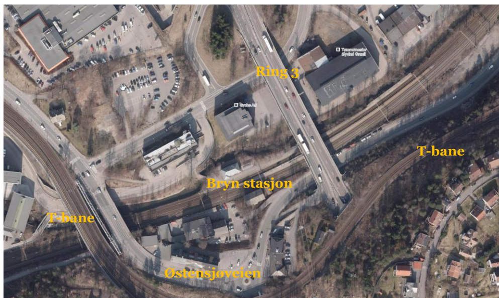
Figur 91: Oversiktsbilde over eksisterende Bryn stasjon
