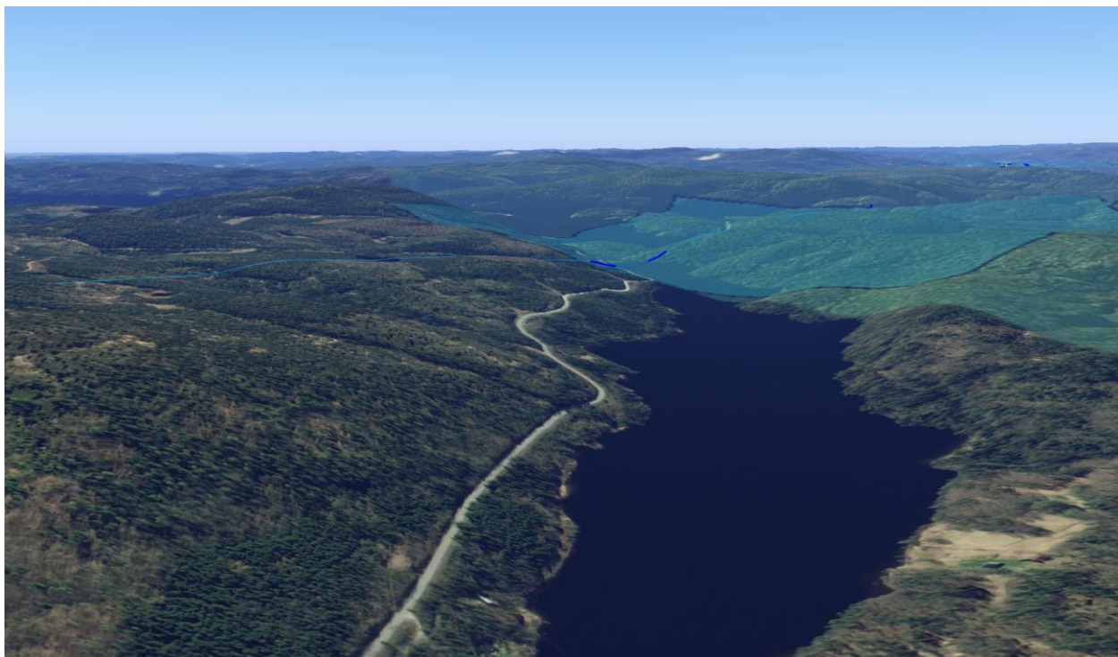
Figur 10-8. Rørholt – Nedre Toke retning sør, bildet viser influensområde (blått) og dagsone (bru) over vann. Illustrasjon: COWI AS.
