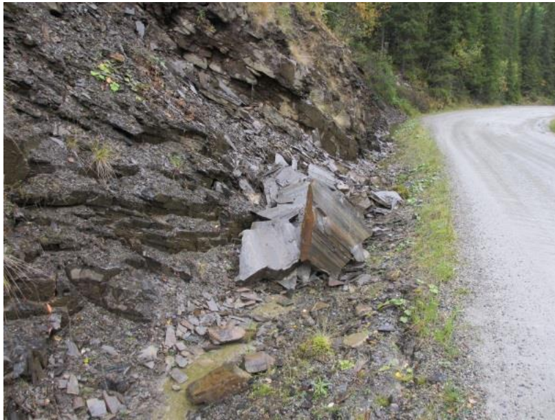
Figur 24) Stein i grøft kan være et startpunkt for iskjøving. Breidalen, Oppland. Foto: A. Liereng.
