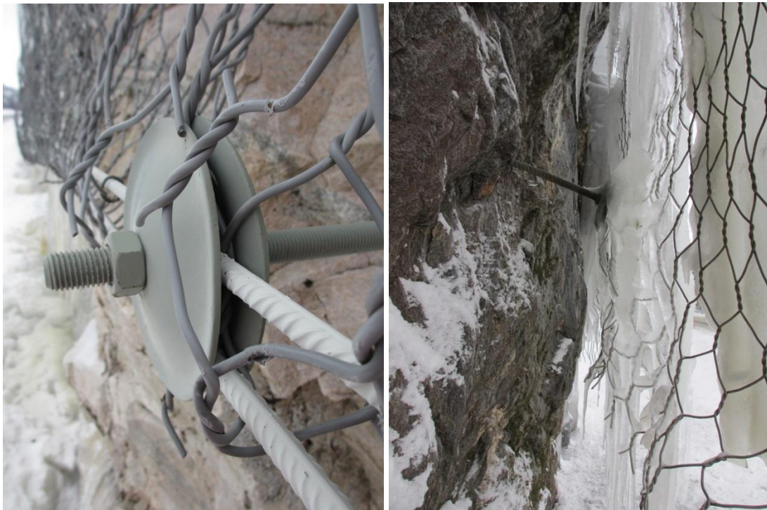
Figur 78a) Nettet avsluttes med en vaier som tres gjennom nettmaskene og boltes fast i berget. Nettet brettes tilbake over waieren og festes. b) Isen vokser fra nettet, slik at vann kan renne på baksiden av isen. Begge foto: A. Liereng.
