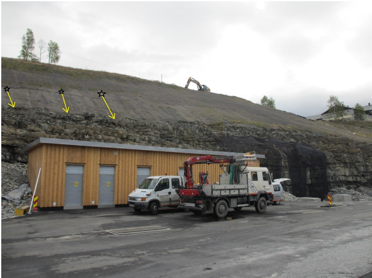
Figur 100) De svarte stjernene viser utspring av grunnvann. Vannet renner ned til fjellskjæringen som vist med gule piler. Vannet fordeler seg utover de flate berghyllene og samles i to nedløp bak teknisk bygg. Foto: A. Liereng (19.5.16).
