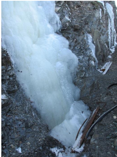
Figur V- 4) Innløpet til stikkrenna er ikke fylt med is. Det er ikke stikkrenna som er årsaken til iskjøvingen i bekken. Foto: A. Liereng (15.1.16).
