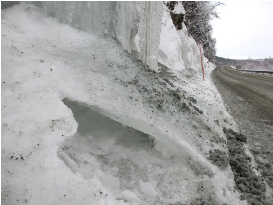
Figur 28) Islokk over snøen i grøfta. Vannet kommer fra en lav skjæring. Fv 30. Foto: A. Liereng
