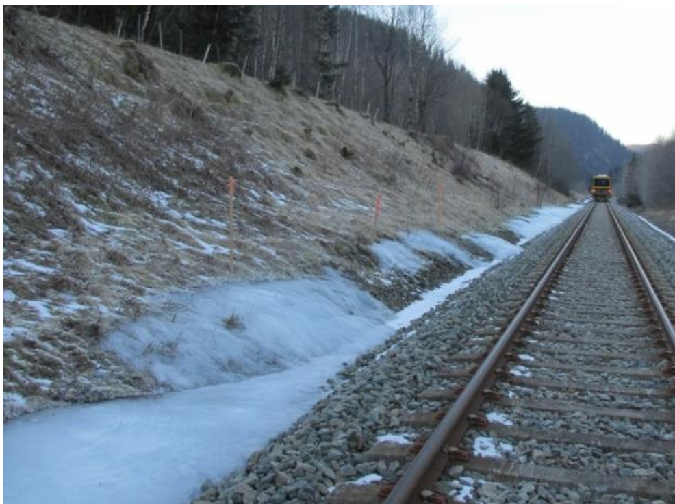
Figur 26) Iskjøving fra siden av grøfta. Vannet som kjøver, renner ut i et markert nivå i jordskråningen. Meråkerbanen. Foto: A. Liereng
