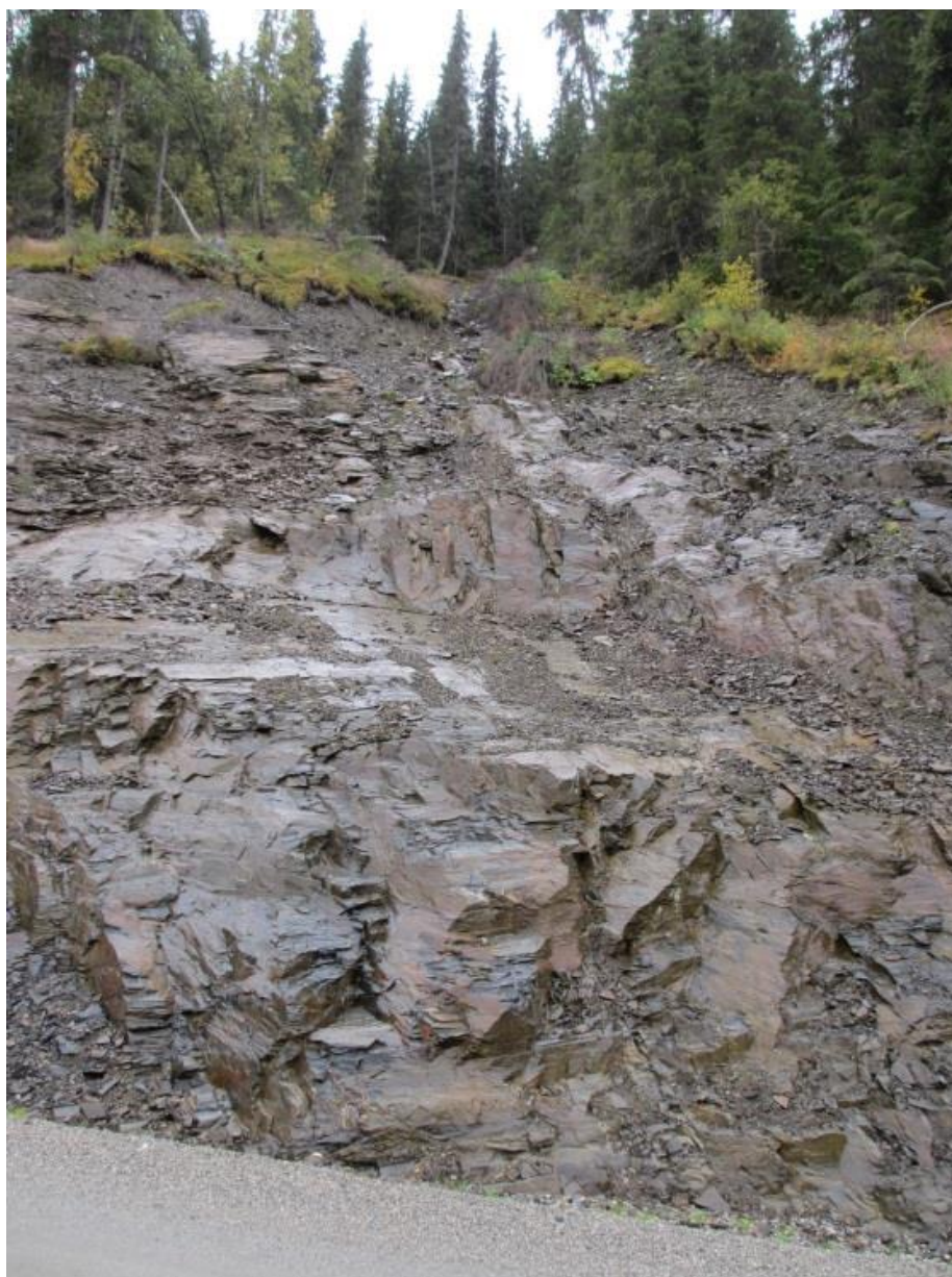
Figur V- 43) Fjellsiden ovenfor vegen er ryddet for løsmasser og vegetasjon etter et jordskred i august 2013. Foto: A. Liereng (20.9.15)
