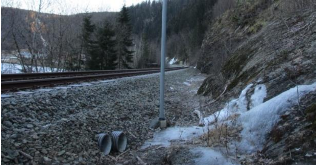
Figur V- 11) To ekstra stikkrenner, plassert et par meter øst for hovedstikkrenna. Disse er tørre og fri for is. Foto: A. Liereng (15.1.16).
