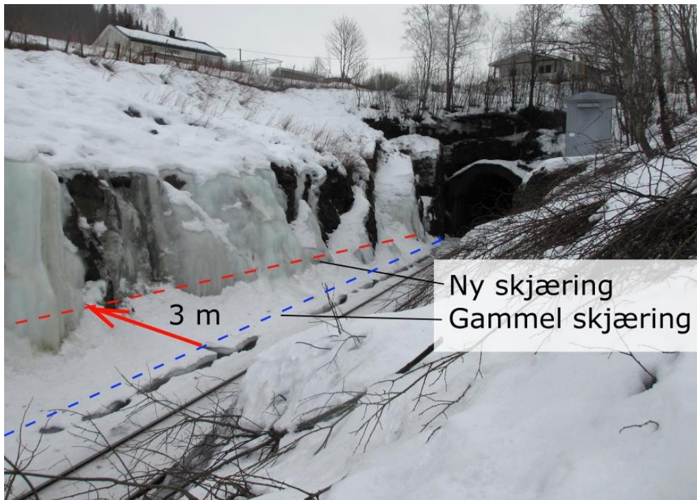
Figur 73) Skjæringen utenfor Dalsklubben Tunnel, Nordlandsbanen er utvidet med 3 m. Blå stiplet linje viser plassering av tidligere skjæring, mens rød stiplet linje viser dagens skjæring.
