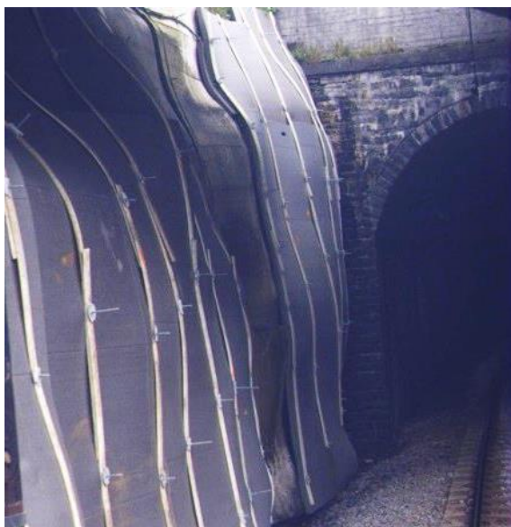
Figur 68a) Isolasjonsplater i skjæring utenfor tunnelportal. Bulken, Bergensbanen (bilde fra målevogn). b) Prinsippskisse av isolasjonplatene.
