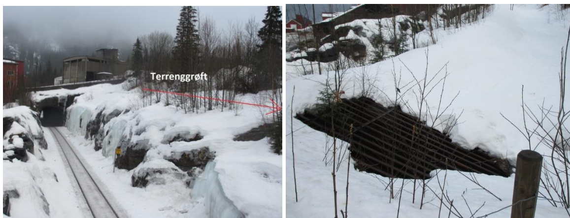
Figur V- 86a) Det er laget en terrenggrøft for å samle vann på oversiden av skjæringen, vist med rød linje (pil i fallretningen). b) Vannet i terrenggrøfta ledes til dette inntaket. Vannet renner ned i en vanntunnel under sporet ut til fjorden. Foto: A. Liereng (15.3.16).
