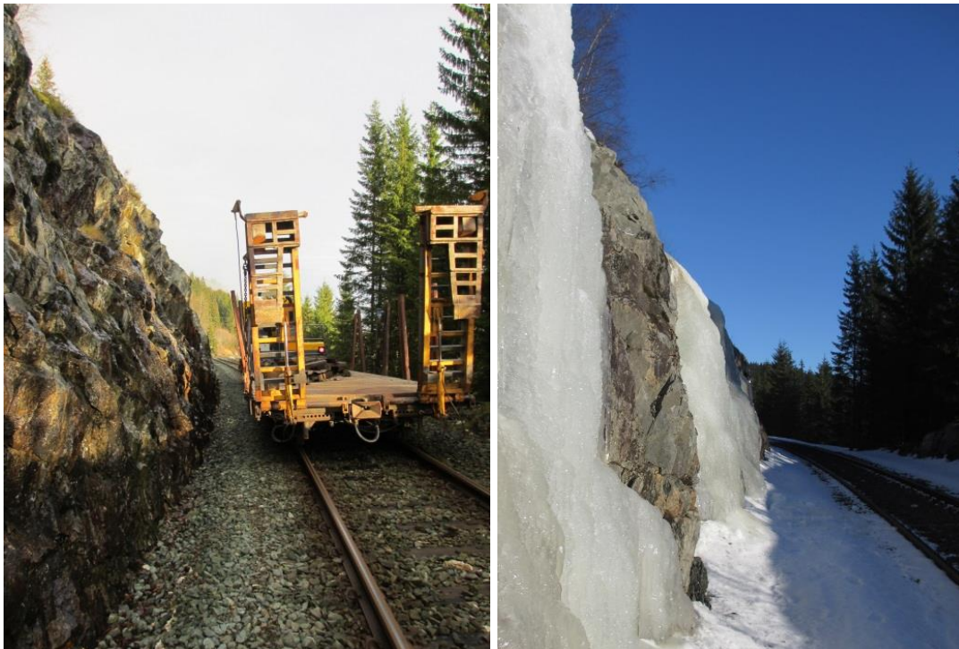
Figur 10a) Trang skjæring langs Meråkerbanen. Foto: A. Liereng (5.11.15). b) Om vinteren kan isen komme i vegen for togene. Foto: A. Liereng (19.2.16).
