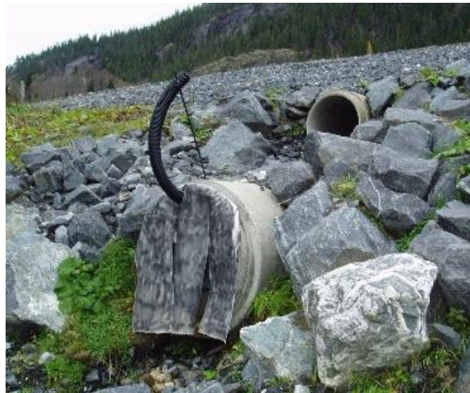
Figur 85) Tre forebyggende tiltak: Frostgardin av fiberduk for å hindre trekk, føringsrør for enkel tilkobling av dampstimplange, og ekstra stikkrenne plassert høyere i underbygningen. Nordlandsbanen, ca. km 400. Foto: Kjell Arne Skoglund
