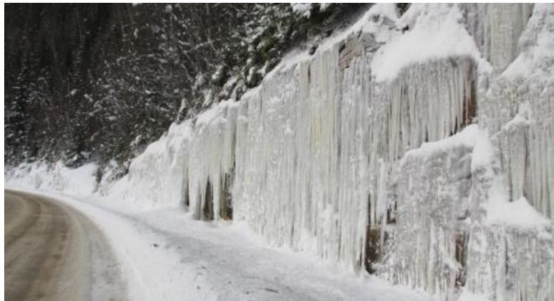
Figur 19) Grunnvann kan forårsake iskjøving over lange strekninger. Fv 30. Foto: A. Liereng.
