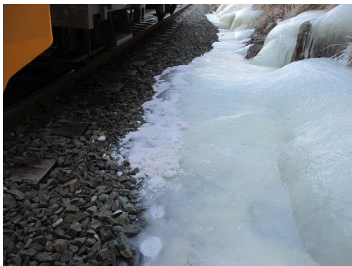
Figur 88) En stripe salt over isen kan hindre isen i å komme ut i sporet. Foto: A. Liereng (15.1.16).
