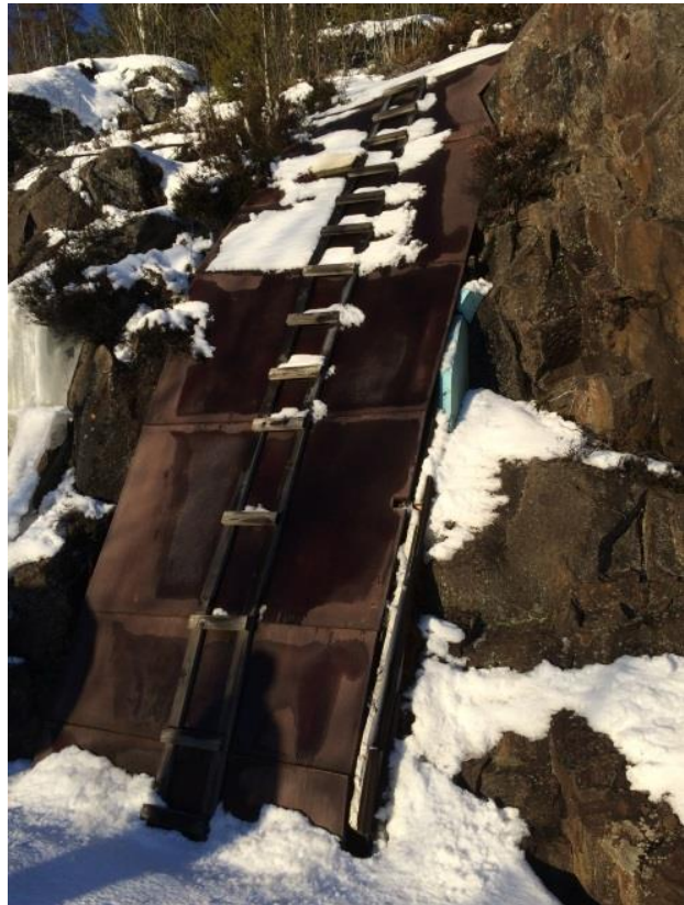
Figur 69) Enkel isolert vegg langs Sørlandsbanen. Foto: Martin Ulleberg (Jernbaneverket Kongsberg)
