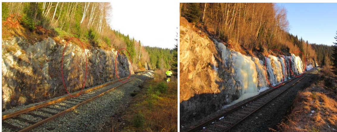
Figur V-27a) Skjæring ved Brennhaugen. Skjæringen er våt, selv i tørt vær. Foto: A. Liereng (5.11.15) b) Iskjøving langs skjæringen starter der løsmassedekket slutter. De røde ringene er plassert på samme sted i de to bildene. Foto: A. Liereng (15.1.16).
