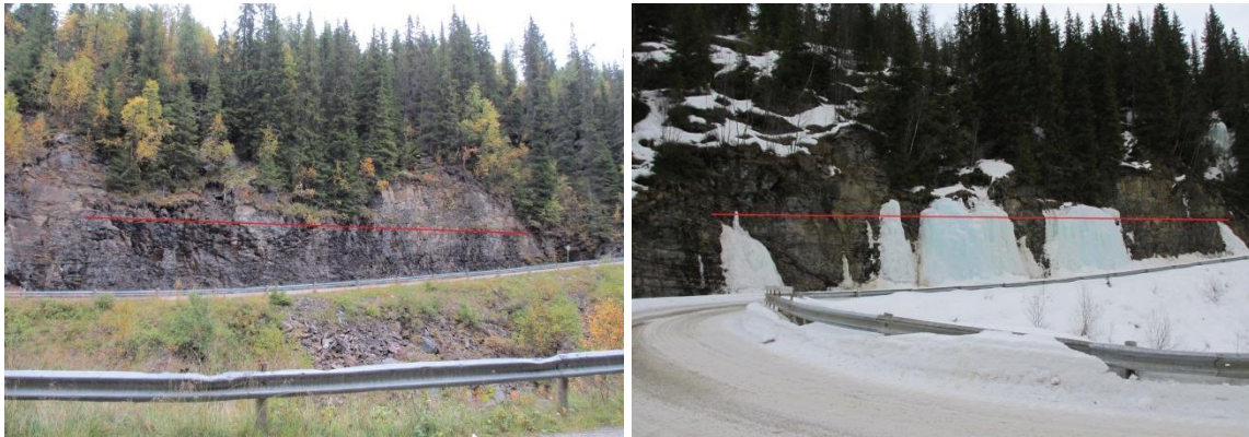
Figur 21a) Den røde linja viser grunnvannsnivået i en skjæring langs Tann-Annolsetervegen. b) Grunnvannet fryser til is og forårsaker iskjøving. Foto: A. Liereng
