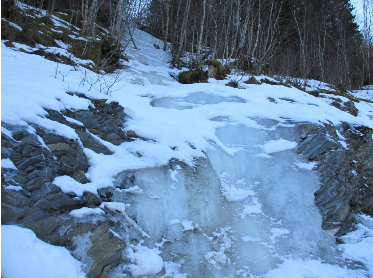
Figur 16) Iskjøving i bekkeløp i skjæring ved Sørkilhaugen, Meråkerbanen. Foto: A. Liereng
