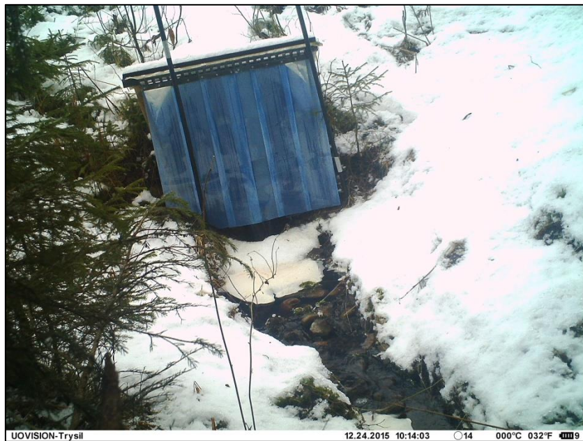
Figur 71. Plastforhengene har fått kondens på innsiden, som har gått over i dråpeform og renner nedover på innsiden av plasten. Bildet er tatt 24.12.15.
