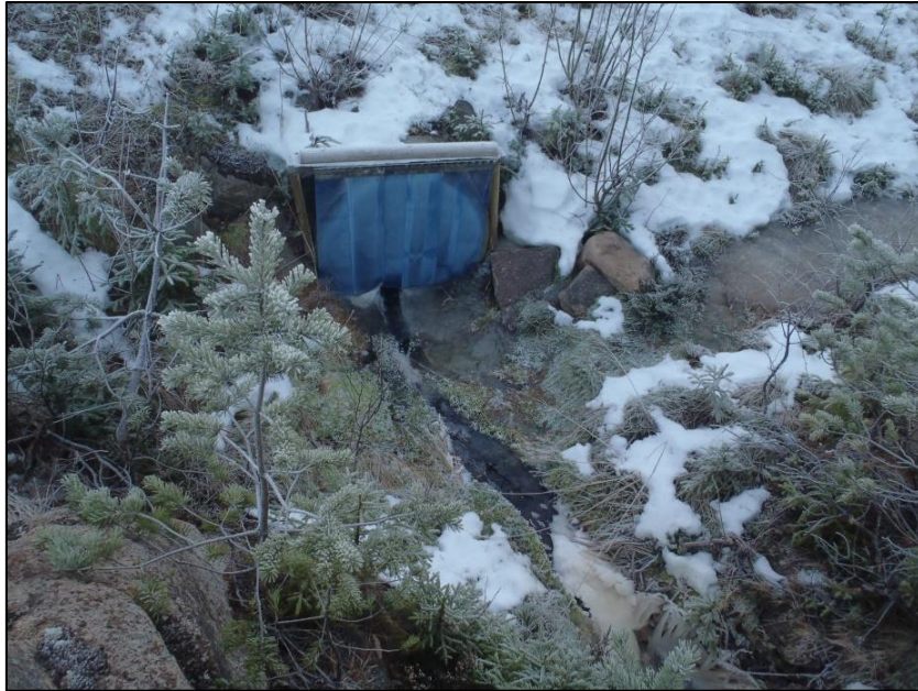
Figur 7. Farget is før innløpet og på siden av innløpet (til høyre i bildet) til stikkrenne Ø3 ved Osensjøen.
