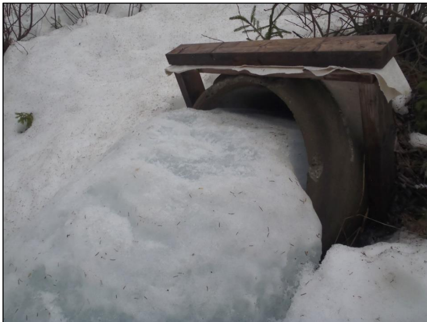
Figur 88. Observert svellis i utløp på stikkrenne Ø2.
