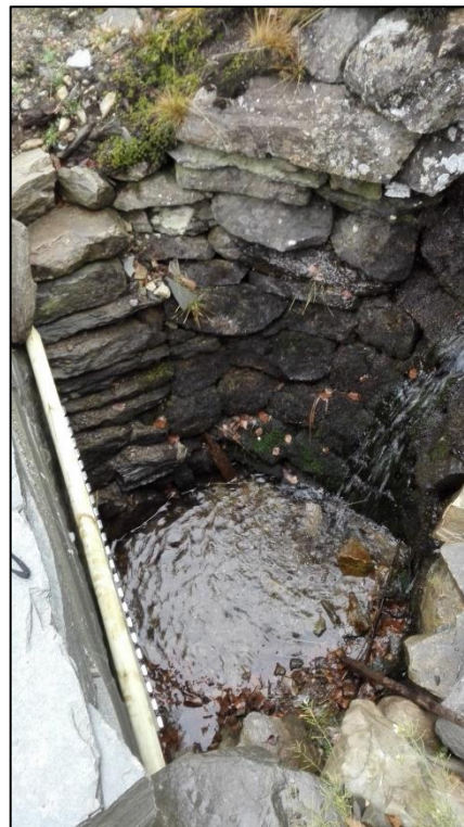
Figur 41. Tilløpet og innløpet til stikkrenne D2, med feste til kuldeskjørt satt opp. Etter den smale rennen er det et sirkulært oppmurt område før selve innløpet
