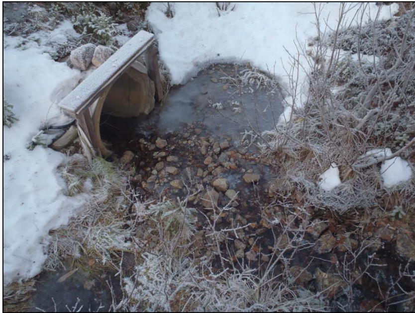
Figur 28. Innløp Ø2. Fiberduken er fjernet i 2015, fra 2013 til november 2015 var det slisset fiberduk ved både innløp og utløp.
