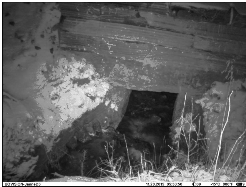
Figur 81. Helt i starten av frysingen. Bekken fryser delvis til, og bygger seg utover og oppover. Bilde fra 20.11.15.
