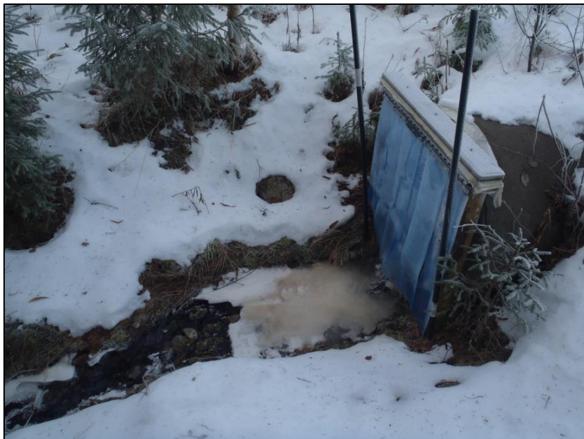
Figur 31. Utløp Ø3, med kuldeskjørt av plaststrimler.
