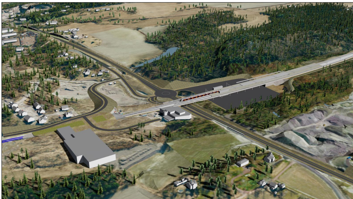
Figur 3-49: Stasjon på Skoppum vest sett mot øst
