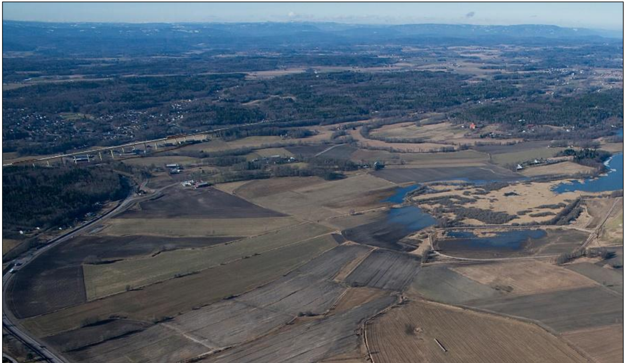
Figur 5-19: Alternativ 2 - Borreskåla og viadukten bak Sandehøyden sett mot nordvest
