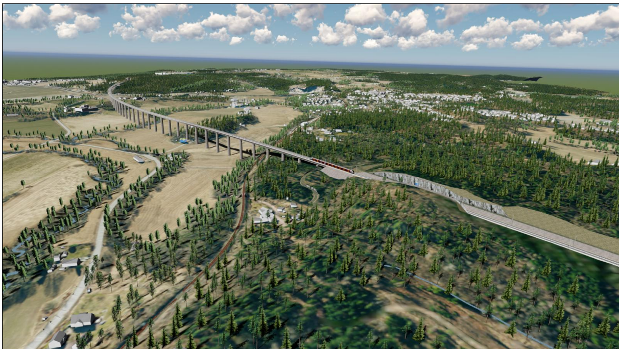
Figur 3-30: Viadukt sett mot sør
