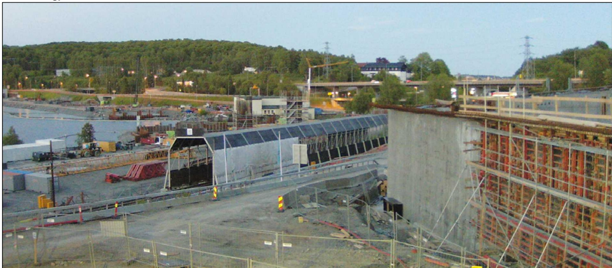
Figur 3-54: Eksempel på beskyttelsesskjerm i anleggsfasen. Fra riggområdet på Farriseidet hvor E18 og jernbanen krysser hverandre. Foto: Statens vegvesen.
