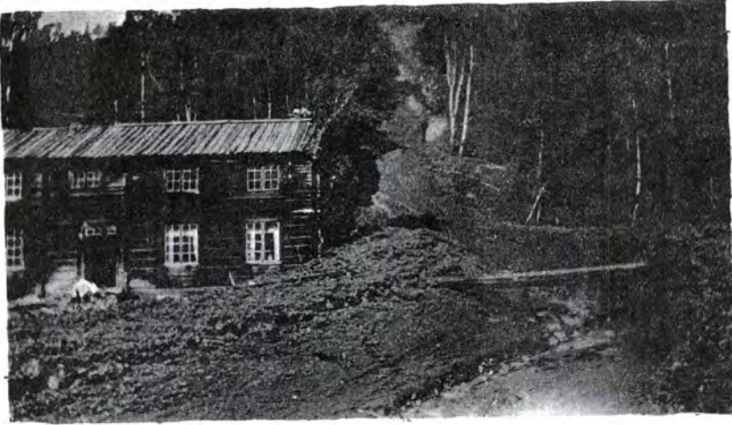
Fig. 17. Raslöp forbi Ormheim gård. Söndre ende av våningshuset tatt av raset.
