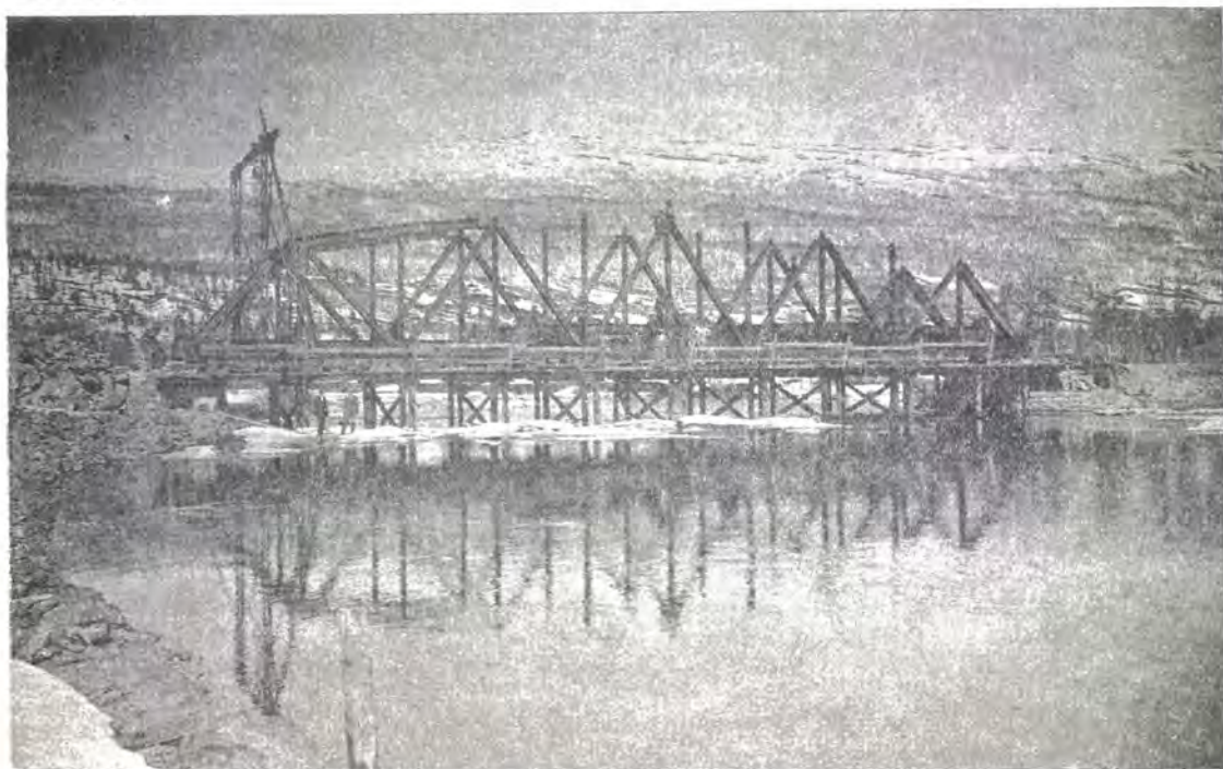
Fig. 40. Bro over Rauma ved Bövermoen. Montering.
