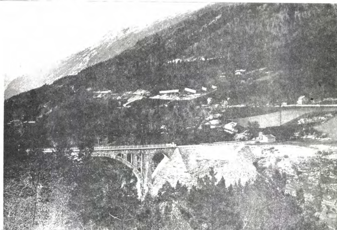
Fig. 34. Kylling bro. Sneoverbygg foran Kylling tunnel. Sneskjermer for linjen sønnenfor Verma stasjon. Nedre og øvre linje.
