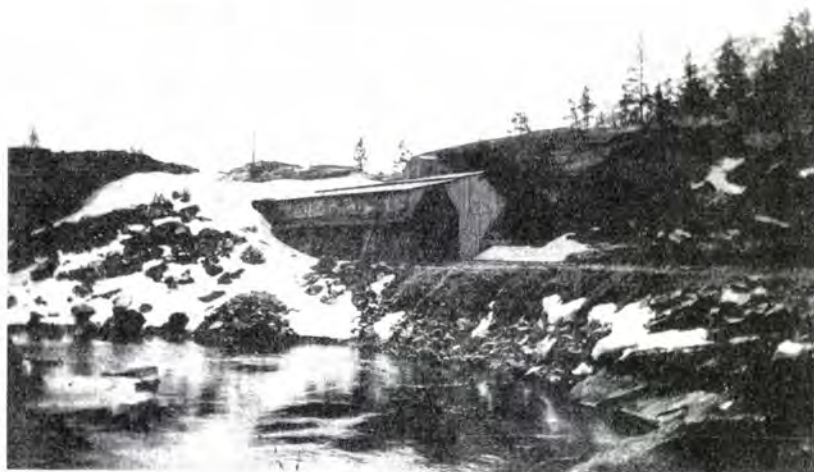
Fig. 11. Bakke tunnel, sneover- bygg. Se side 168.
