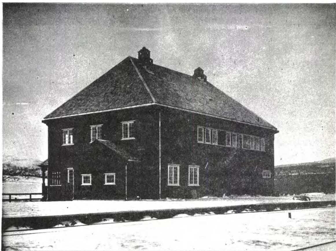
Fig. 57. Stasjonsbygningen. Tegnet av arkitekt Arnstein Arneberg. Nu brent.
