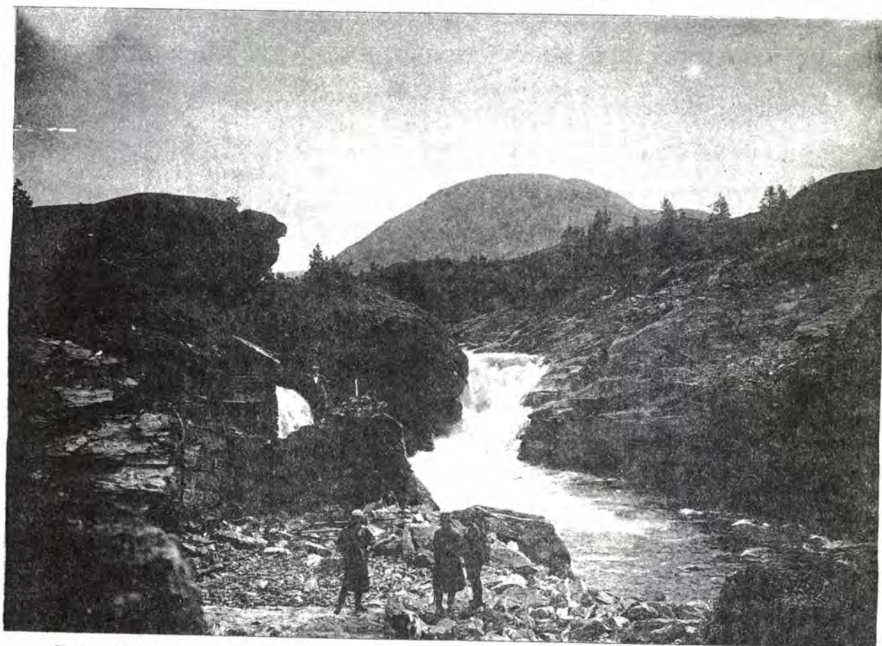
Fig. 28. Brostedet. Fundamentutsorenningen utført.
