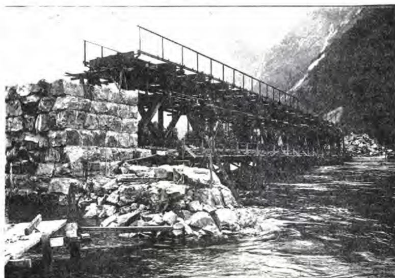
Fig. 42. Storflom under monteringen.
