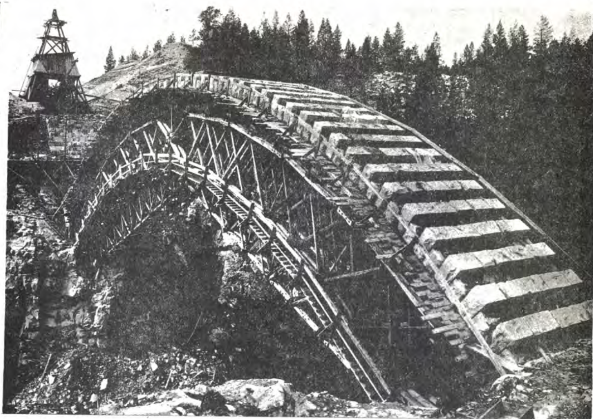
Fig. 24. Jora bro. Förste hvelvring utlagt.
