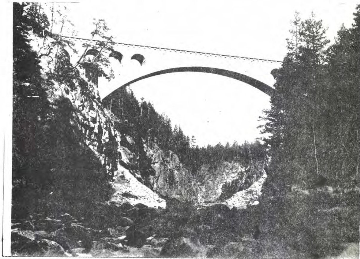
Fig. 25. Jora bro ferdig.
