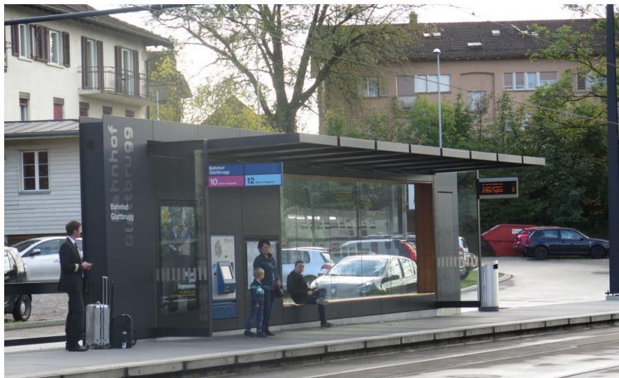
OERLIKON: Trikkestopp ved S-bahnstopp. Ytre by. Foto: Hedda Klemetzen
