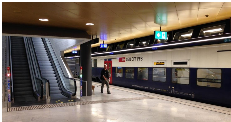
HAUPTBAHNHOF, NY DEL: Lyse flater og mange trapper på de nye plattformene i den nye delen av stasjonen. Kanten over trappesjakten er utformet slik at røyken ikke stiger like raskt opp til neste etasje ved brann. Foto: Terje Grytbakk
