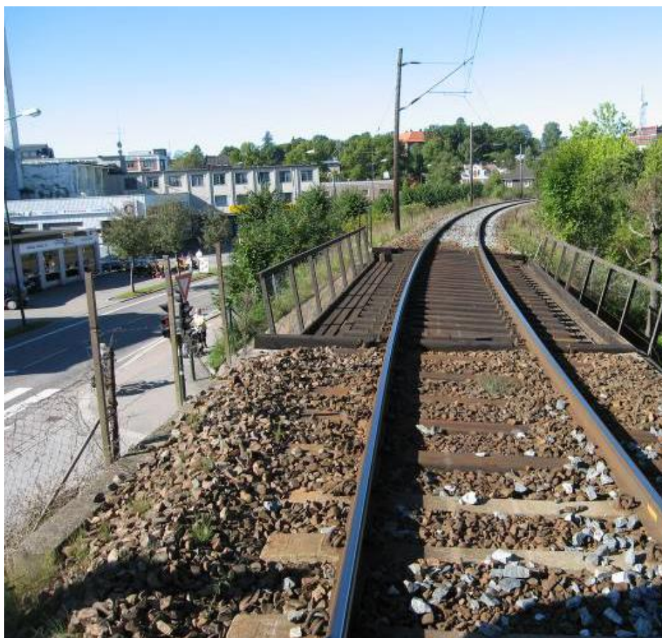
Undergang: Byggeår 1922, Tvillingbærer på gamle landkar i stein, spennvidde 10,7 m
