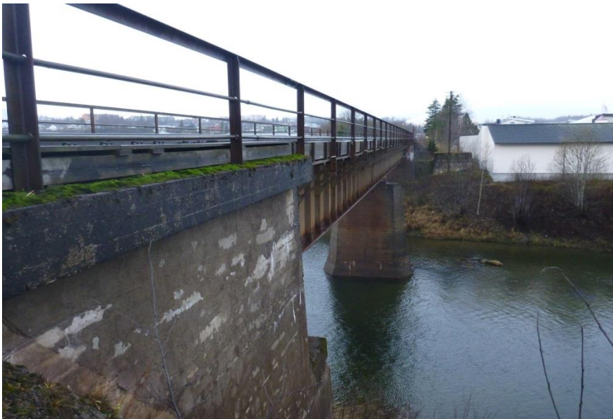
Bru over Tverråga Km 501,590
