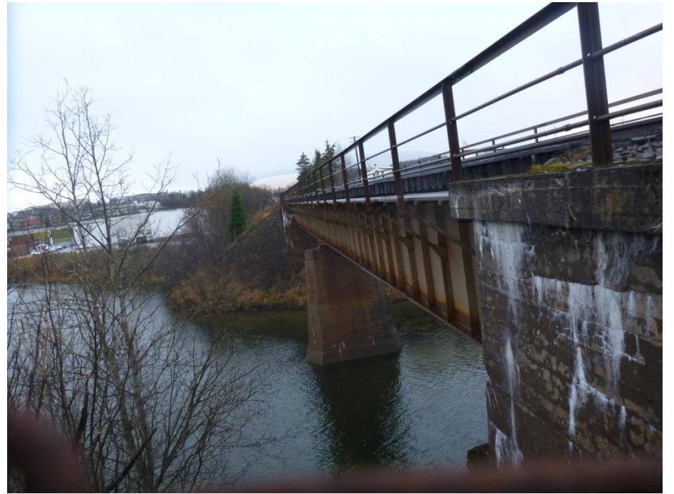
Bru over Tverråga Km 501,590
