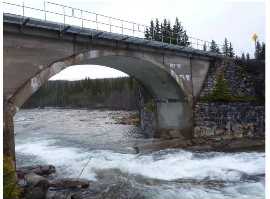
Bru over Grønnfjellåga Km 528,805
