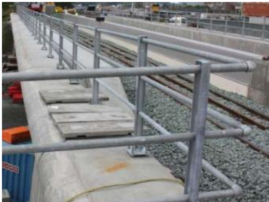
Den nye løsningen for rekkverk i JD 525, Del. 4, figur 2
