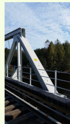
Bilde 6: Rekkverk
