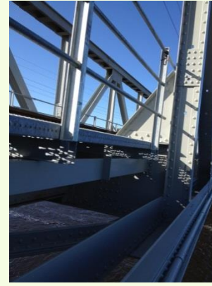
Bilde 3: Ut isolert bjelke
