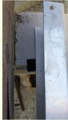
Bilde 2: Ut isolert bjelke
