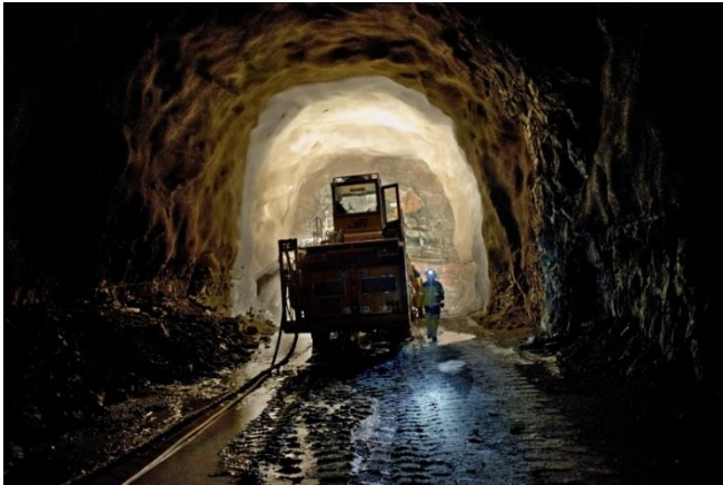
Tverrslag i tunnel ved Mjøsa. Foto: Hilde Lillejord/Jernbaneverket
