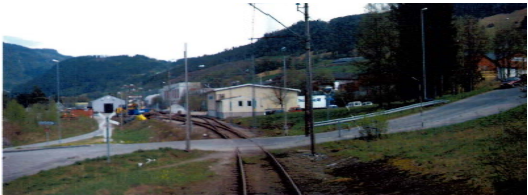
Figur: Bilder fra Palmafossen planovergang (Jernbaneverket).
