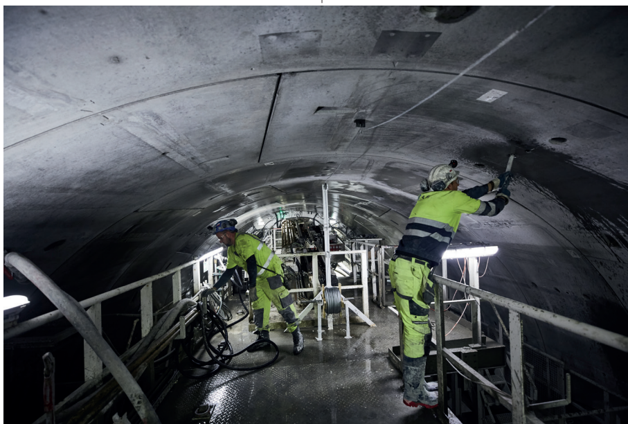
Tunnelboremaskiner (TBM) er tunnelfabrikker som borer og forsegler tunnelen i en operasjon. I dette bildet ser du to tunnelarbeidere ved den fremre delen av maskinen.
