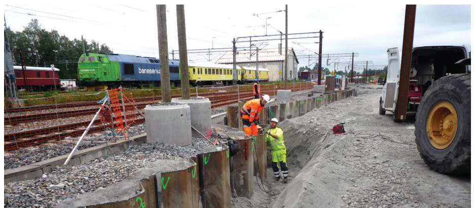
Bildet viser anleggsarbeider på Ski stasjon i juli 2012.
