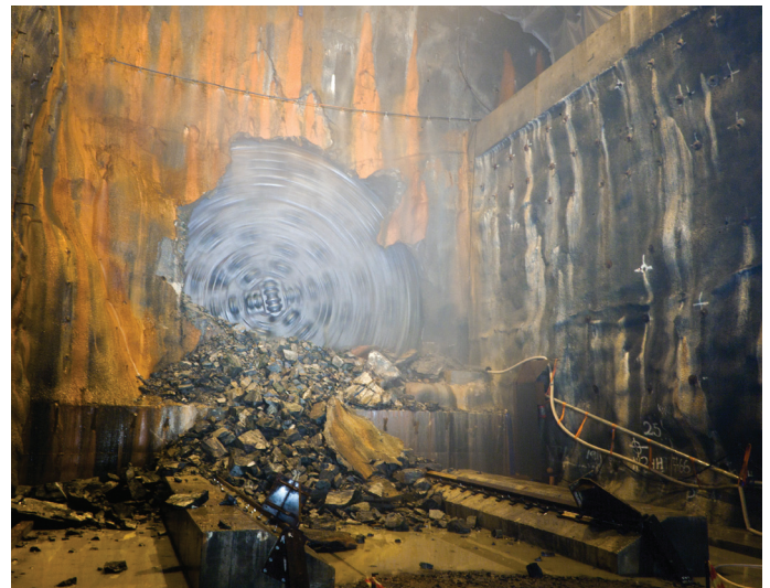
Gjennomslag med tunnelboremaskin i Hallandsåstunnelen Sveirige. Foto Svenske Trafikverket
