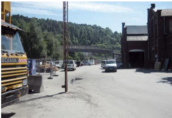
Figur 87 Foto av eksisterende situasjon øst for verkstedbygningen. Foto: Jernbaneverket/Aas-Jakobsen
