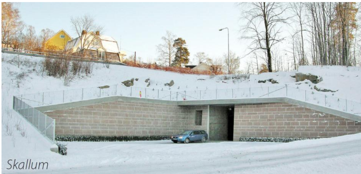
Figur 92 Eksempel på utforming av tverrslag med beredskaps plass for Bærumstunnelen som ferdig anlegg. Eksemplet er relevant for tverrslaget ved Furubråtveien. Foto: Jernbaneverket
