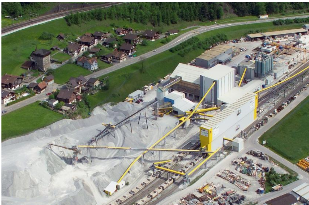
Figur 67 Eksempel på riggområde knyttet til TBM-drift. Materialhåndteringsstasjon inkludert gjenbruks- og lastestasjon for vogner i Amsteg, Sveits. Foto: © AlpTransit Gotthard Ltd.
