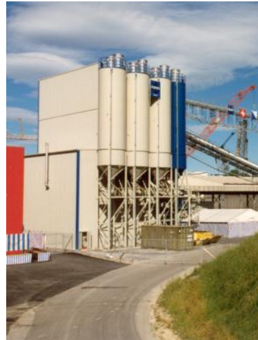
Figur 71 Betongfabrikk med siloer for lagring og lastestasjon. Foto: Jernbaneverket/Amberg.
