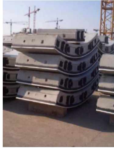
Figur 69 Stabledede betongelementer klare for montering. Foto: Jernbaneverket/Amberg
