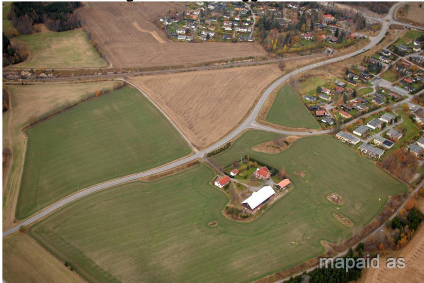
Oversiktsbilde: Skråfoto (2007) med Halfstad gård i forgrunnen. Diagonalt gjennom bildet går Fv 152 Åsveien. Videre ser man jordene, jernbanen med tunell-innslag og boligfeltene (kilde: Follokart; skråfoto)
