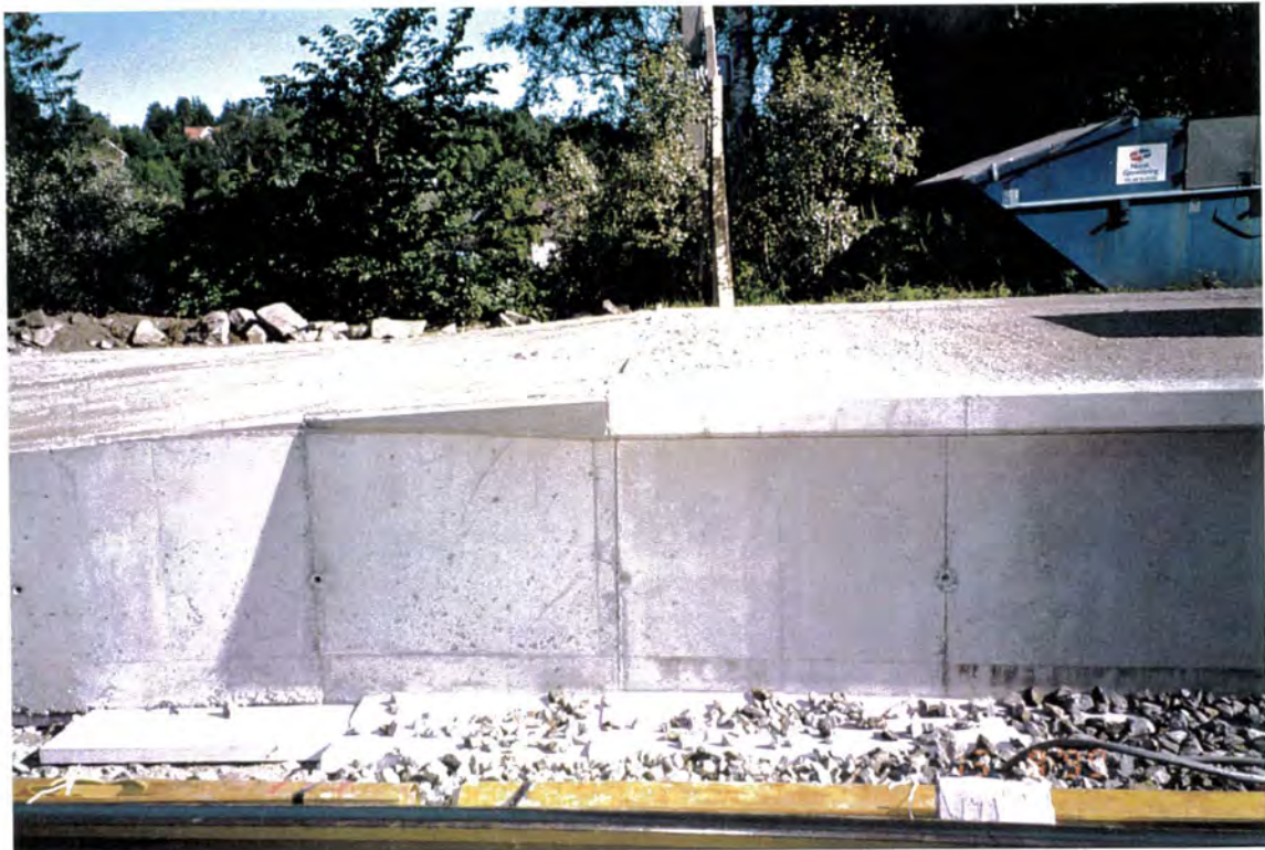
Overgang mellom rampe og plattform
