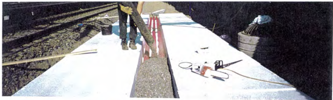
Utlegging 1. lag EPS-blokker
