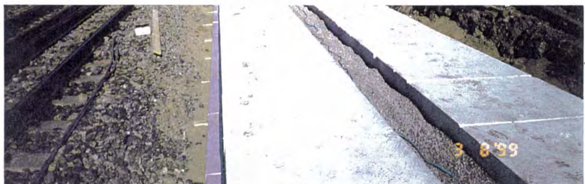
Omfylling av kabelrør med singel, trekkesnor i hulrom
