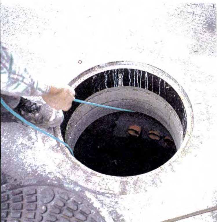
3. Trekking av kabel
