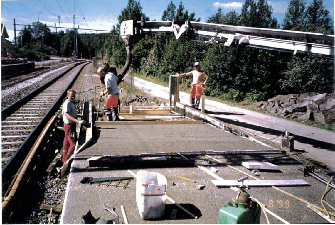
Støp av rampe fra ny planovergang
