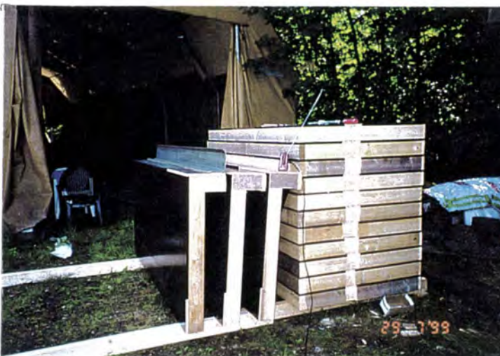
Produksjon av 2 m lange forskalingselementer til front og bakside
