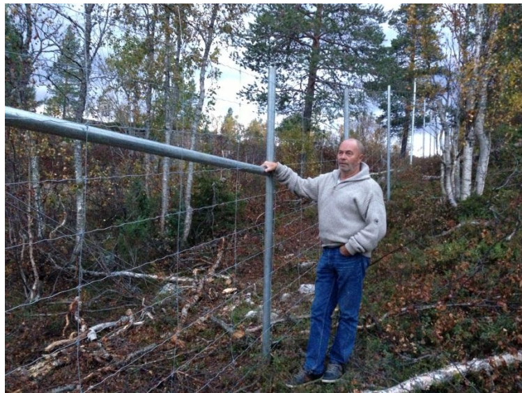
Bilde 2: Gjerder for å hindre påkjørsel av tamrein i Holmvassdalen. Settes opp av JBV.
