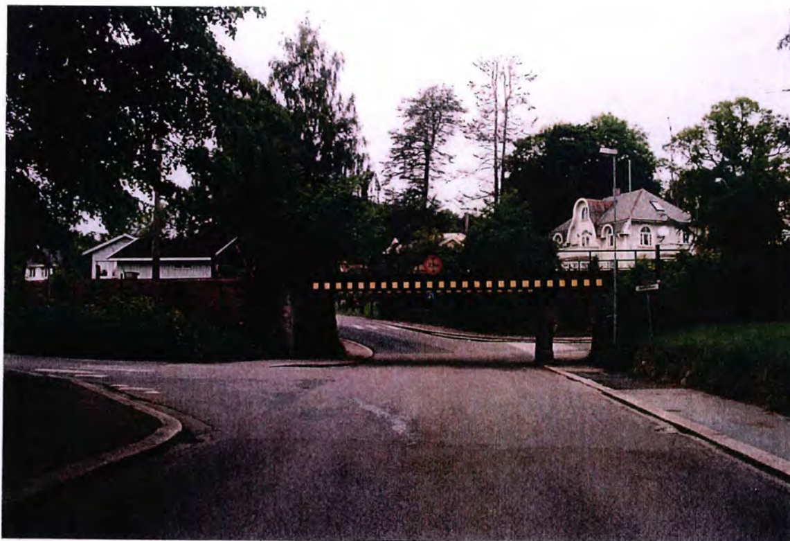
Dølebakken ved jernbanebrua. Over; sett mot nord, under; sett mot sør. For å bedre situasjonen ved denne undergangen vurderer NSB å heve sporet med ca. 2m.
