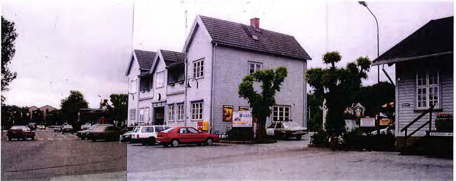
Sandefjord stasjonsbygning og godshus sett fra bysida.
