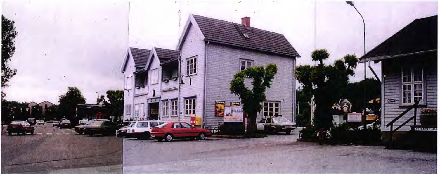
Sandefjord stasjonsbygning og godshus sett fra bysida.
