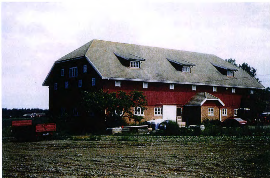
Stor driftsbygning på Grønneberg fra 1942 i forseggjort utforming med detaljer fra flere stilretninger.
