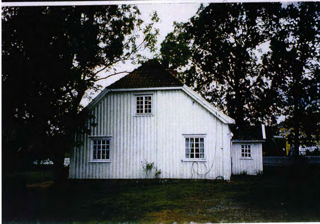
Framhuset på Søndre Gjerstad 1034/2 er et typisk empirehus fra 1840.
