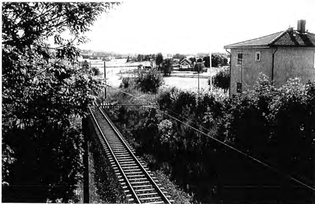
Over: Dagens jernbane sett sørover fra overgangen til Bærløkka. Funkisvillaen til høyre vil bli berørt av alternativ R2.
