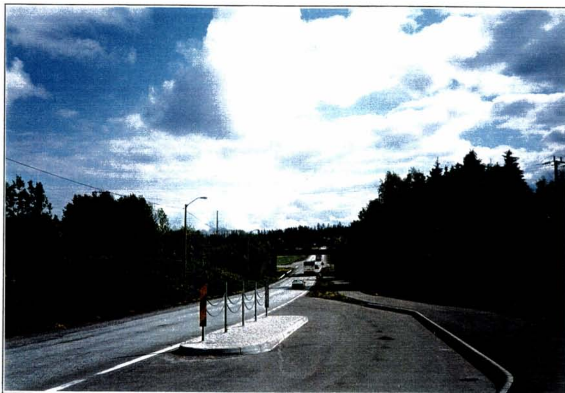
Figur 6.2.6: Dagens jernbanekulvert for Rv. 310 på Nykirke
