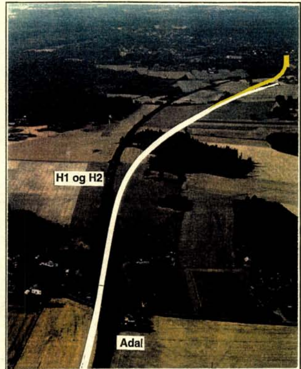
Figur 2.8.12: H1 og H2 sett fra Adal og nordover mot Skoppum
