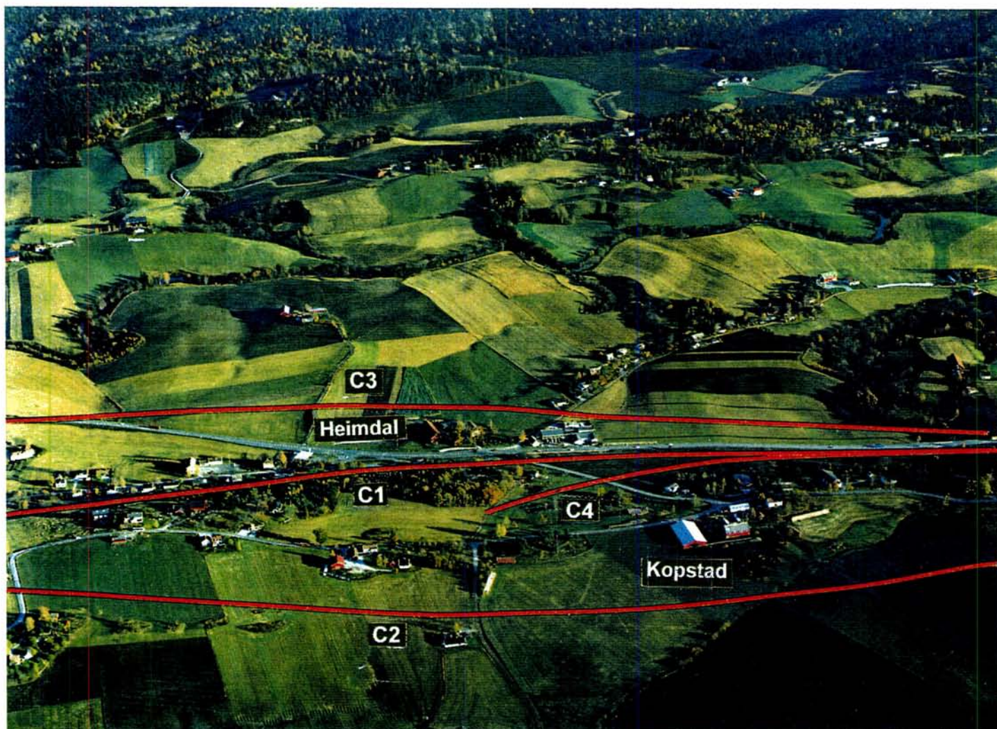
Galleberg. Traséene ved passering av Heimdal og Kopstad gård.
