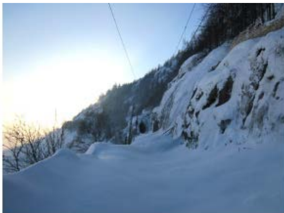
Figur 34 Snøskred ved Sandvikodden, dekket linjen rundt 100-150 meter [70]
