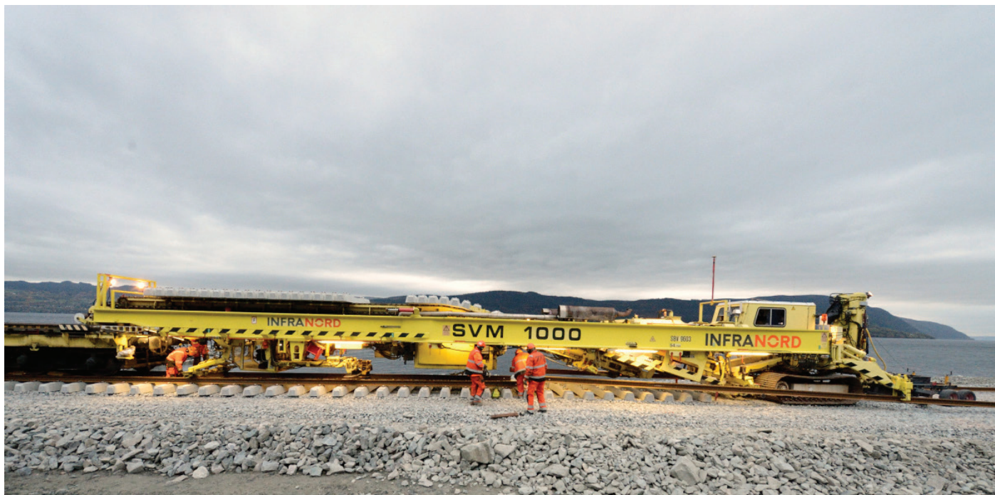
Her er sporbyggetoget, som kommer til Porsgrunn i uke 17, i aksjon på Dovrebanen høsten 2015. Foto: Øystein Grue, Jernbanedirektoratet.
