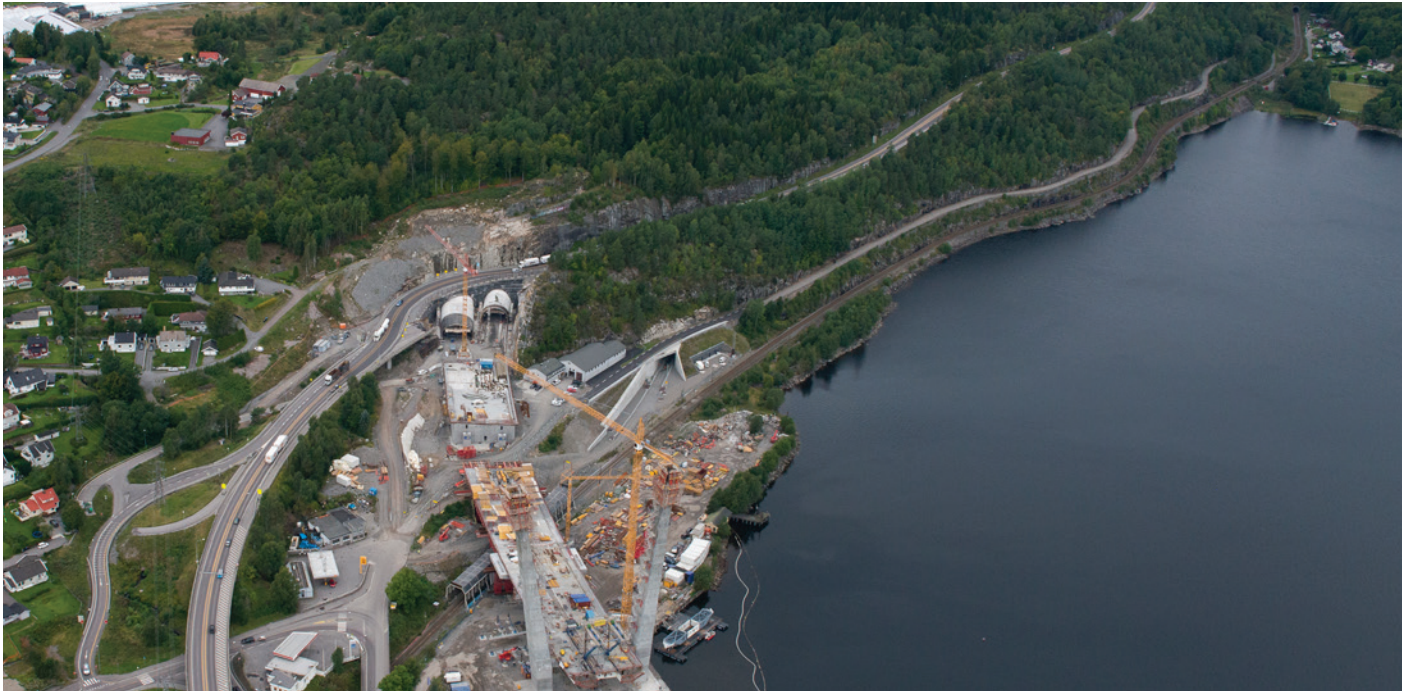
Det gamle sporet langs Farrisvannet fjernes når det nye dobbeltsporet åpner i september 2018. Hva de ulike delene av den gamle banen skal bli brukt til er ikke avklart i skrivende stund, men Jernbaneanlegget er positive til å finne samfunnsnyttig bruk. Foto: Anne Mette Storvik, Jernbaneanlegget.
