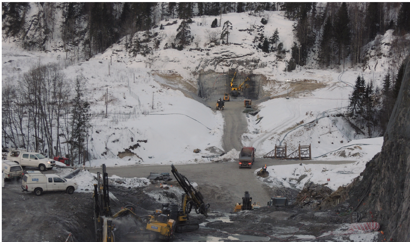
Oversiktsbilde fra Herregårdsbekken. Bildet er tatt fra Storberget tunnelens fremtidige tunnelåpning, mot Eidanger tunnel som kommer midt i bildet. Det vi ser er påhugget som er selve veggen vi begynner å sprengre ut selve tunnelen i. Vegger og området forran påhugget kalles forskjæring og det er inngangen til selve tunnåpningen. Foto: Christian Gangstø Jernbaneverket
