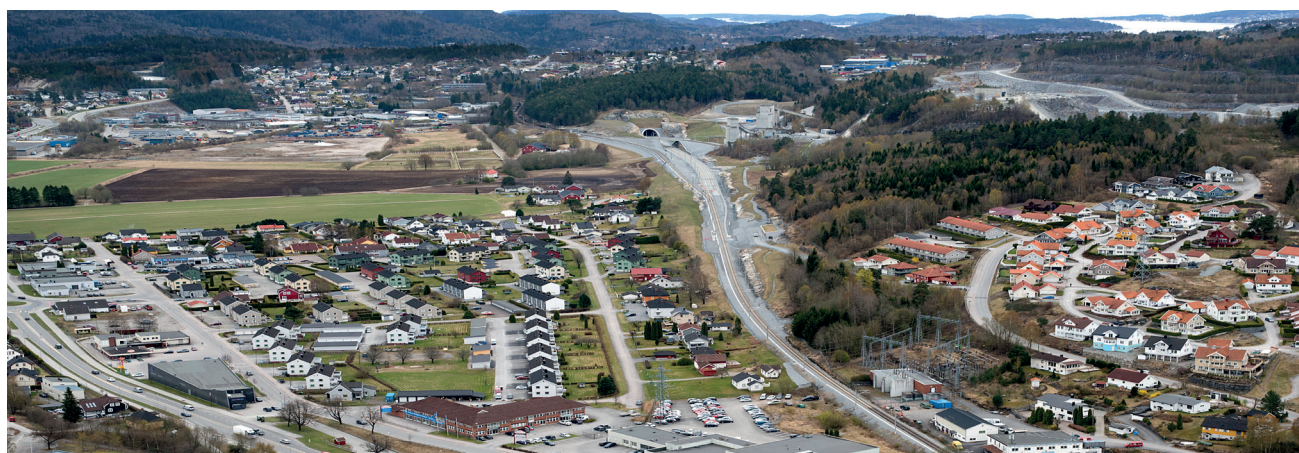
Sporet ligger klart på Vallermyrene i Porsgrunn. Nede til høyre i bildet kan vi se at sporet skifter farge. Det er der prosjektgrensen går. Det lyse sporet er det som er bygd nytt, og den første biten er enkeltspor før vi kan se at det utvider seg til to spor. Foto: Anne Mette Storvik, Bane NOR
