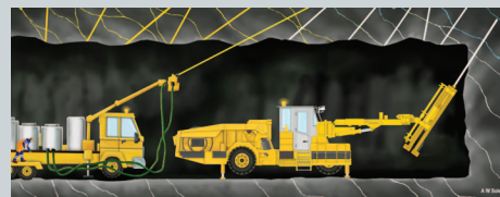
1. FORINJEKSJON Normalt bores 21-27 meter lange hull rundt hele tunnelvernsnittet. Sementmasse pumpes inn i hullene under høy trykk.
