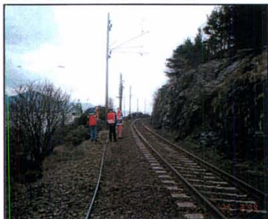
Figur 5: Befaring sør for Kvaleberg, der nytt spor kommer til venstre for eksisterende spor. Gammelt kontaktledningsanlegg erstattes med system 20.
