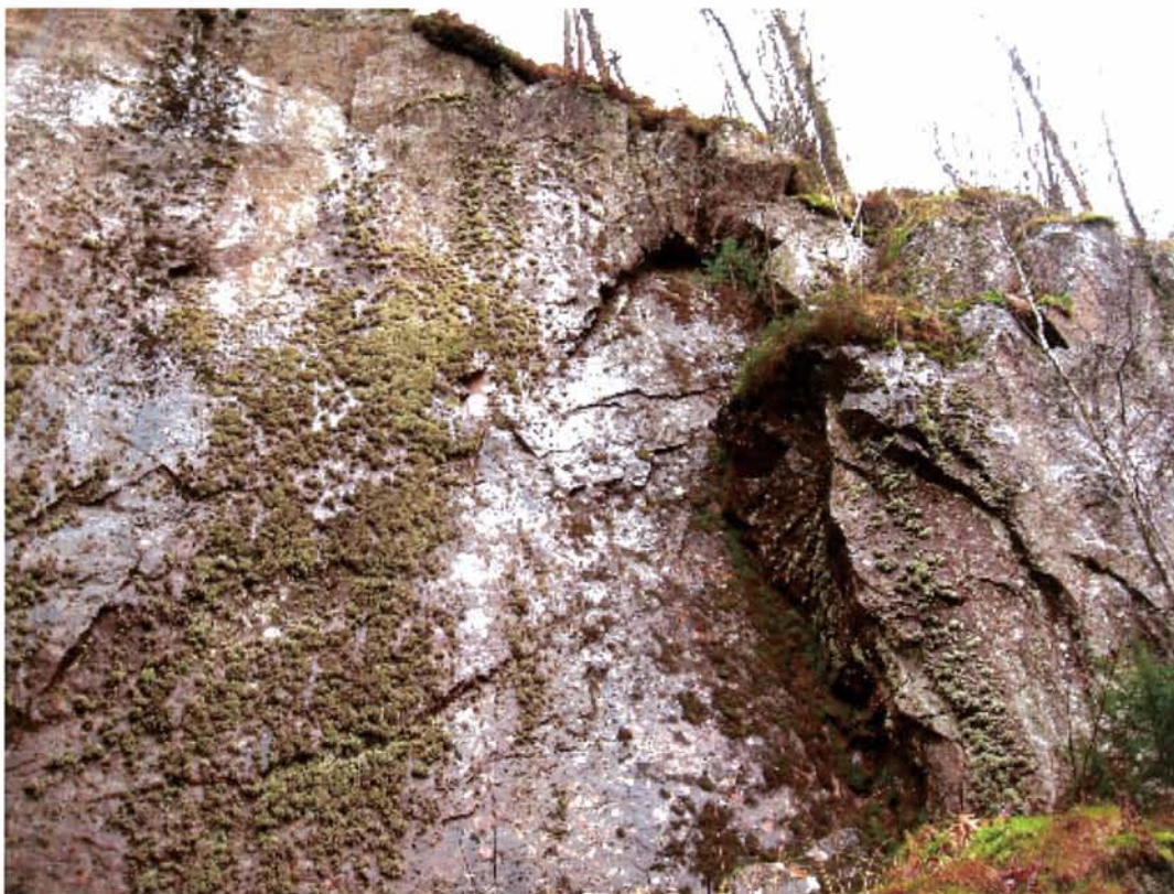
Km 1,023 13 Nov 2008 kl 13:55 Bakkekleivi tunnel S
