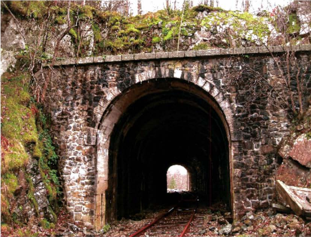
Km 0,960 13 Nov 2008 kl 14:04 Bakkekleivi tunnel N
