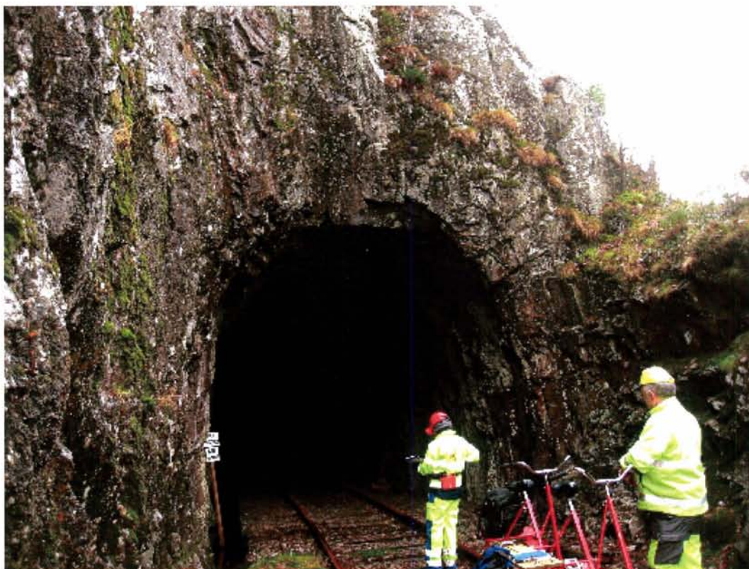
Km 3,330 13 Nov 2008 kl 13:09 Skjeggestad tunnel N
