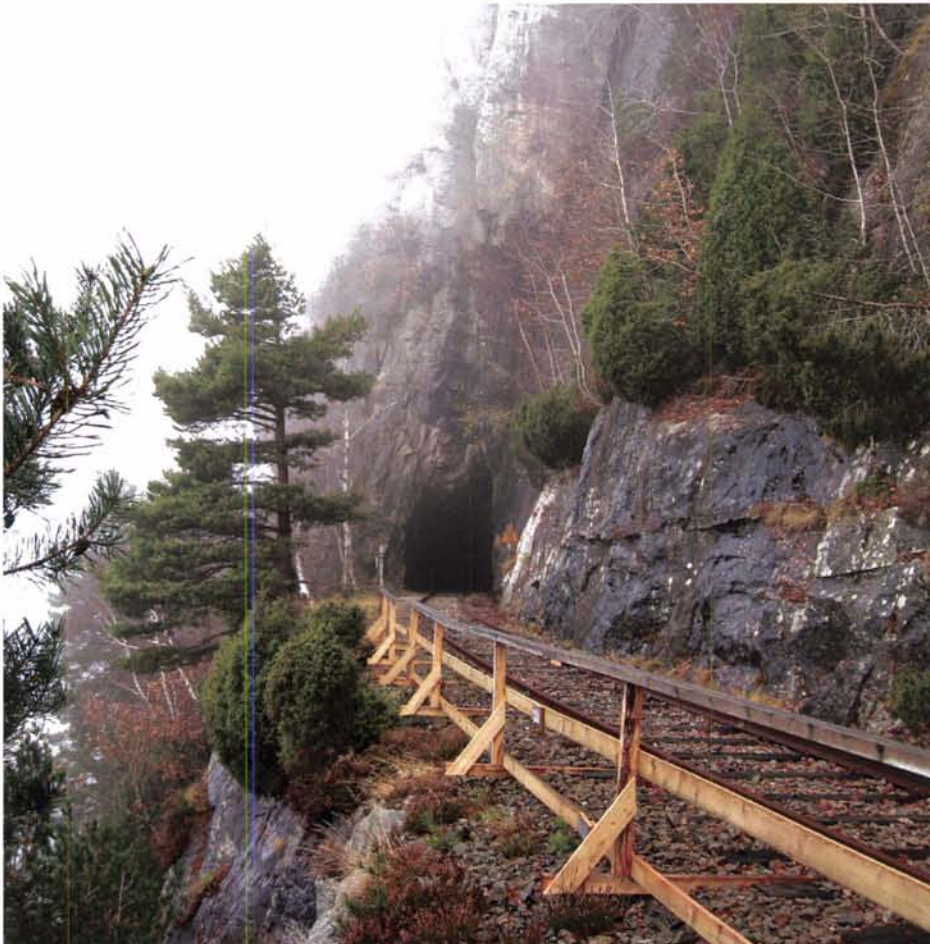
Figur 3 Uoversiktlig og bratt sideterreng sør for Migaren tunnel, ved km 5,19
