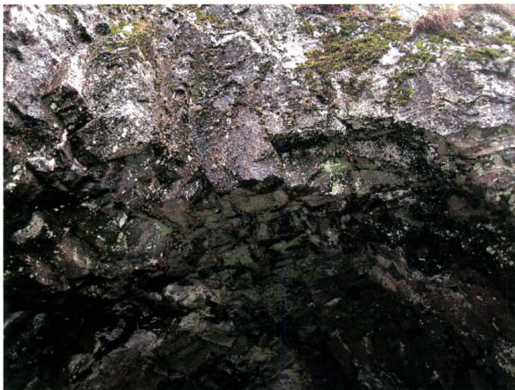
Km 3,330 13 Nov 2008 kl 13:09 Skjeggestad tunnel N
