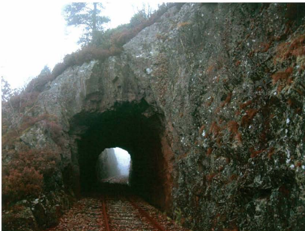
Km 7,290 13 Nov 2008 kl 10:01 Eie tunnel II S
