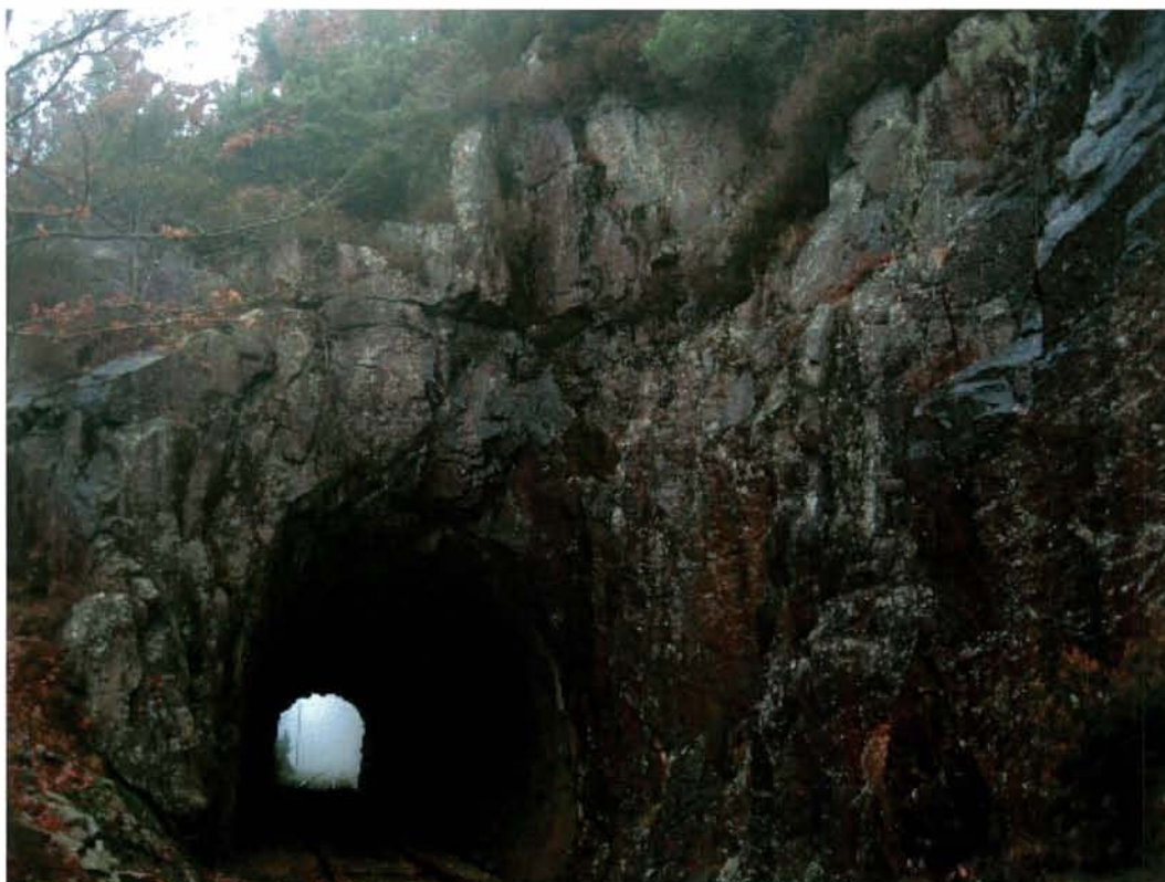
Km 8,112 13 Nov 2008 kl 08:56 Eie tunnel | S
