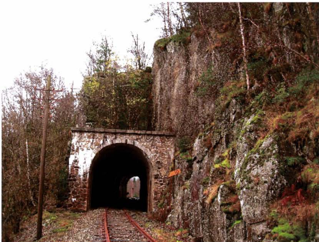
Km 1,023 13 Nov 2008 kl 13:51 Bakkekleivi tunnel S
