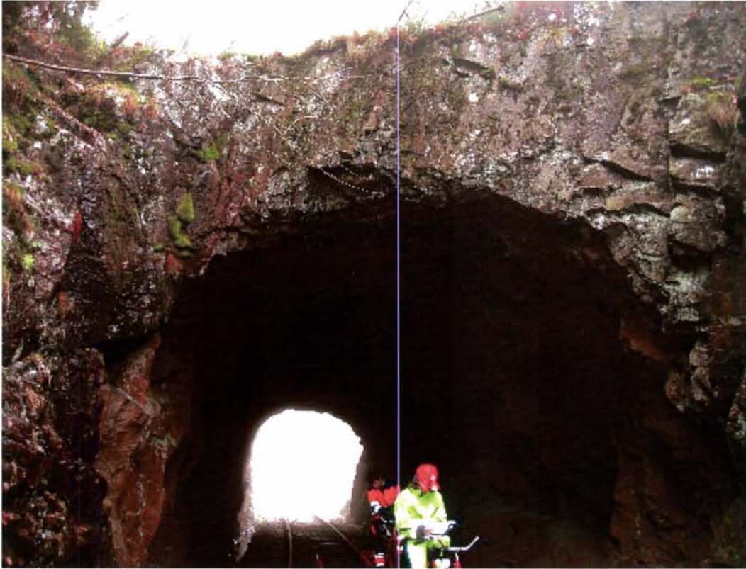
Km 7,260 13 Nov 2008 kl 10:01 Eie tunnel II N
