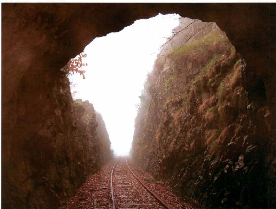
Km 7,260 13 Nov 2008 kl 10:01 Eie tunnel II N
