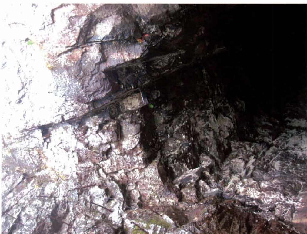
Km 5,340 13 Nov 2008 kl 11:19 Ravnejuvet tunnel N
