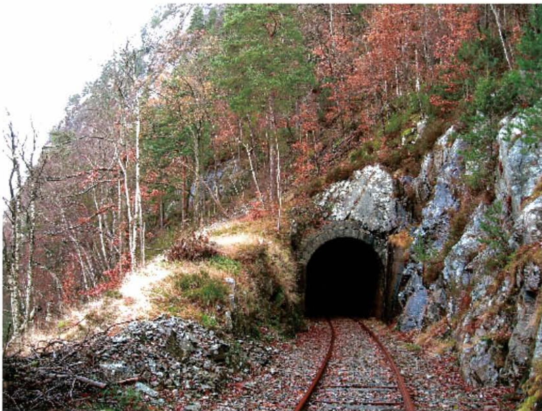
Km 3,873 13 Nov 2008 kl 12:50 Skjeggestad tunnel S
