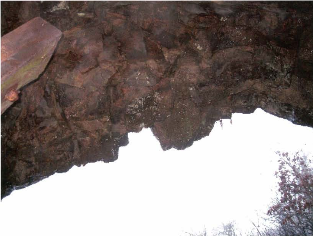
Km 8,060 13 Nov 2008 kl 09:11 Eie tunnel I S
