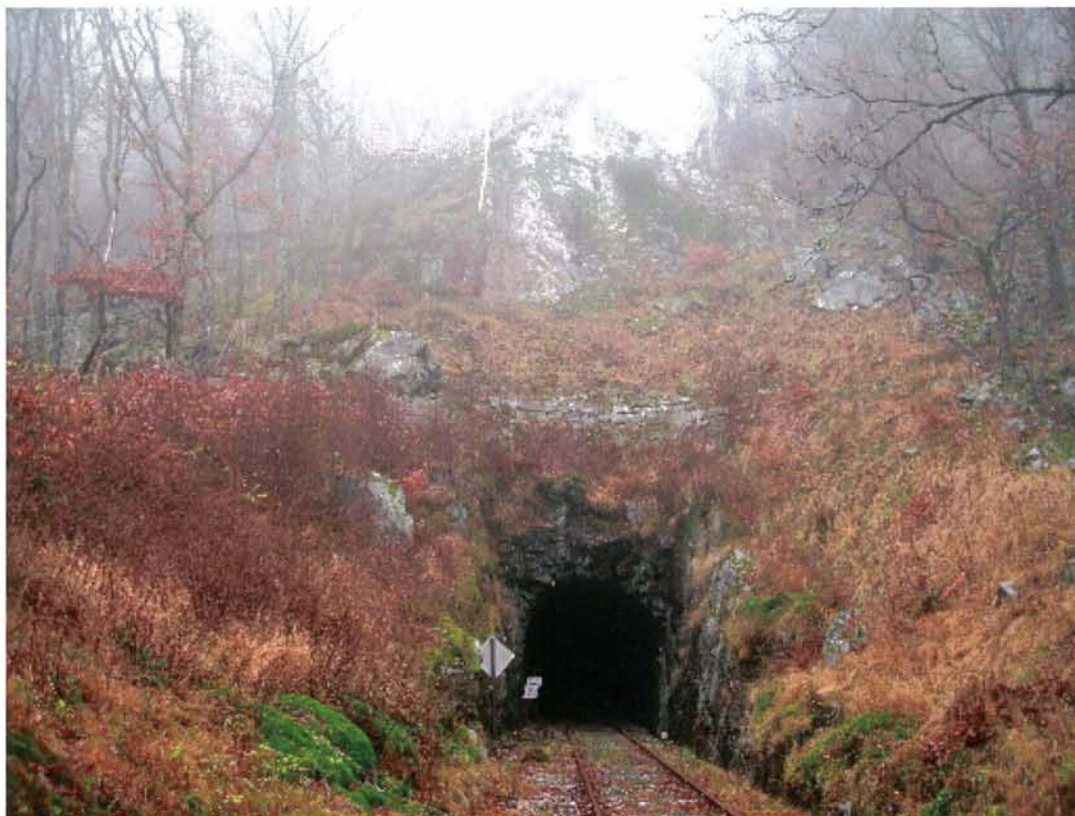
Km 6,514 13 Nov 2008 kl 10:54 Ravnejuvet tunnel S
