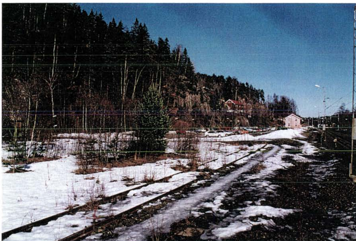
Stasjonsområdet sett fra sør. Til venstre et forfallent fjellanlegg (nedlagt tilfluktsrom?).
