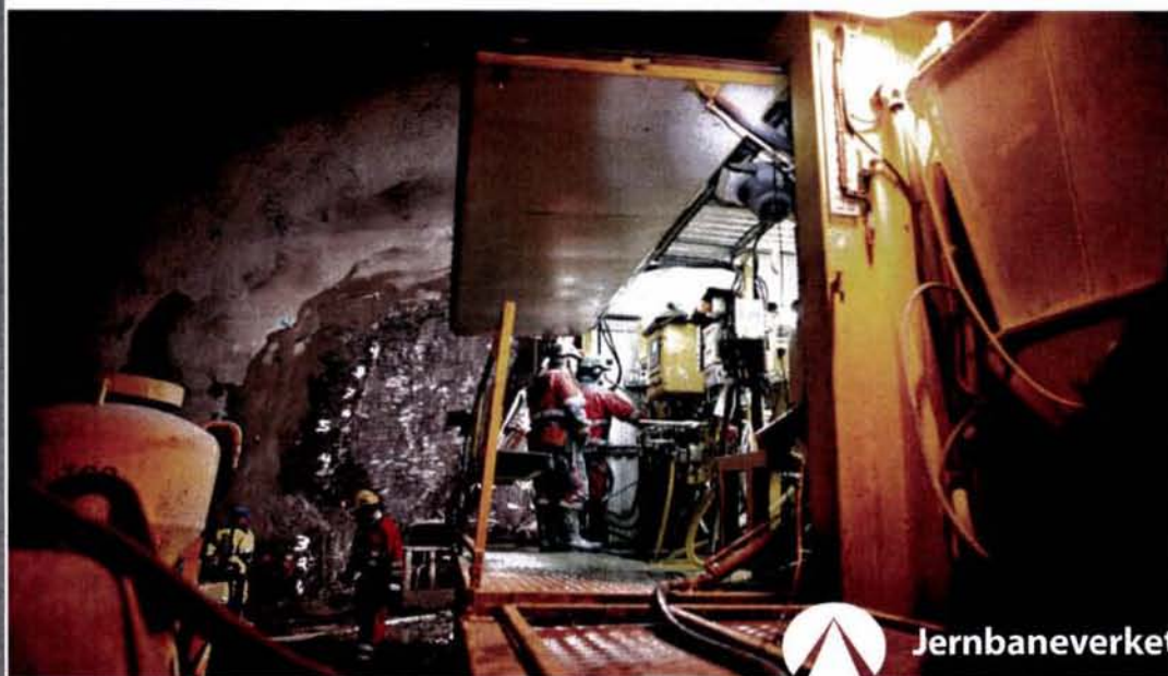
Injeksjon. Før hver sprengning pumpes store mengder sementmasse inn i fjellet. Dette forhindrer lekkasjer fra grunnvann inn i tunnelen. Foto: Hilde Lillejord.
