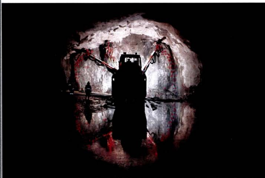
Boring. Før hver sprengning bores det opp til 70 hull på 20-25 meter rundt hele tunnel-tverrsnittet. Foto: Hilde Lillejord.
