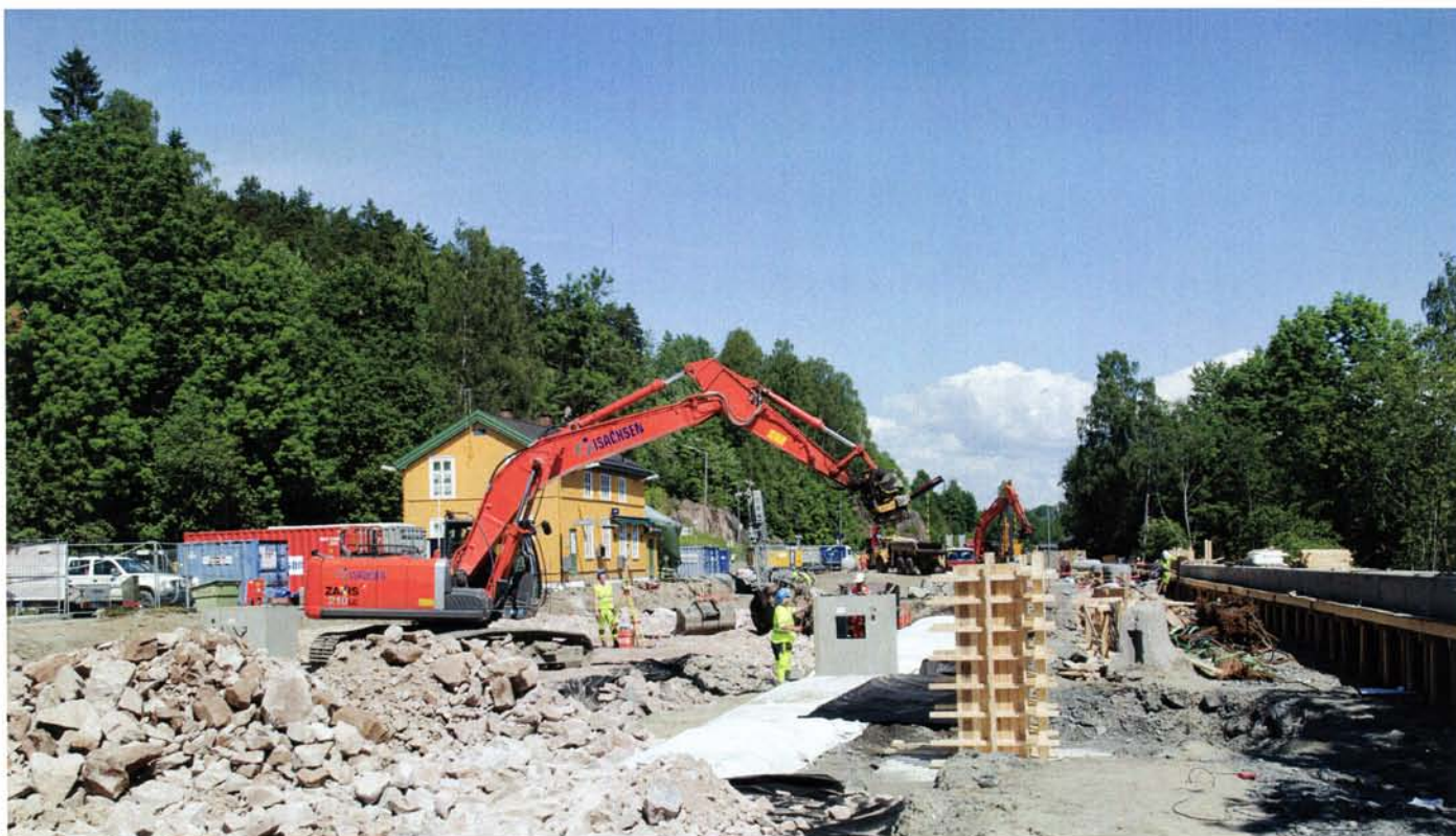
Peab har revet alt av spor, skinner og sviller på stasjonen og er i full gang med oppgraderingsarbeidet. Foto: Hedda Nossen
