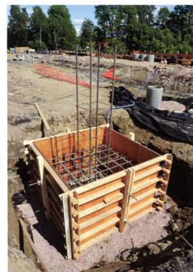
Bildet viser nytt fundament for ny kontaktledningsmast.
