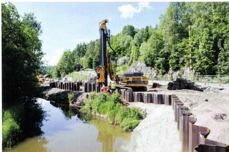
Vi setter ned spunt over en strekning på ca. 30 meter for å stabilisere grunnen mot Skitthegga.
