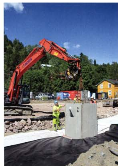
Vi setter ned fundamenter til nye kummer for nytt dreneringssystem.
