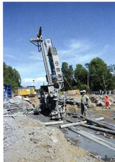
Bildet viser boring av stålkernepeler til gang- og sykkelbroen over stasjonen.
