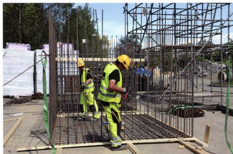
Her lager Peab armering for fundamenter til nye kontaktledningsmaster.
