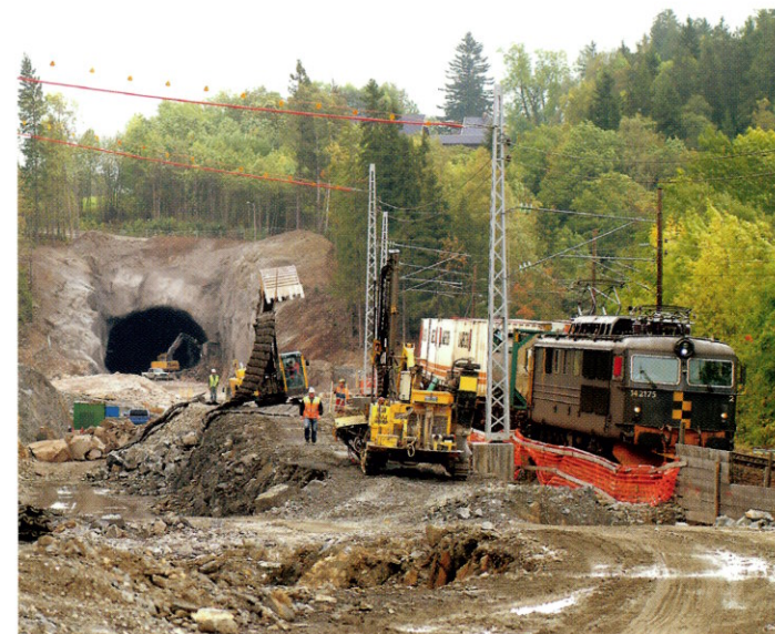
Prosjektet gjennomfører risikoanalyser i forkant av alle anleggsetapper og spesielle arbeidsoperasjoner.
