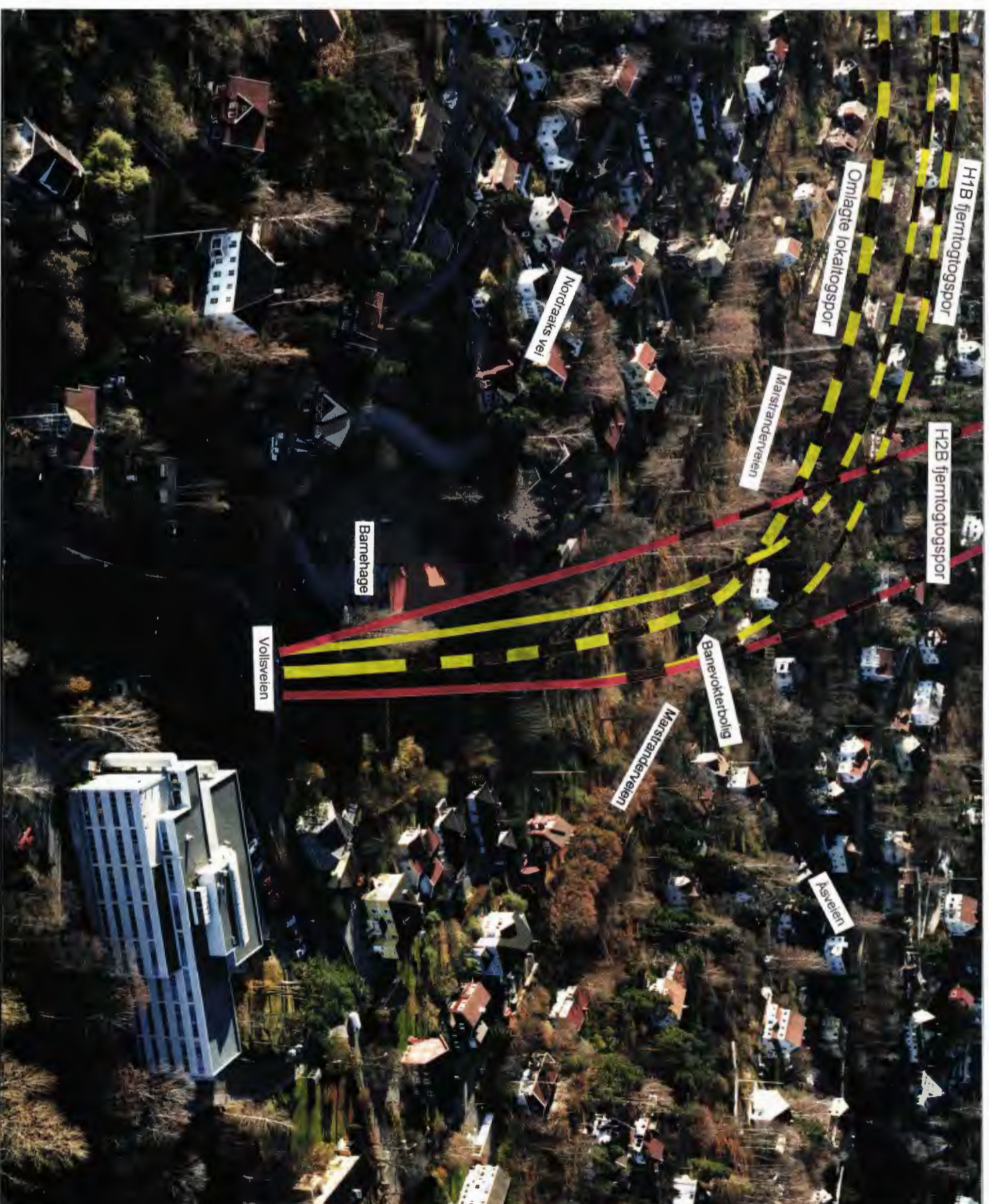
Fig. 8.5.1 Lysaker vest sett fra Vollsveien mot vest. Rød linje er hurtigtogspor for alternativ H2B. Smale gule linjer er hurtigtogspor for alternativ H1B og tykk gul linje er omlagte lokaltogspor for alternativene H1B og H2B. (Fotonor AS)
