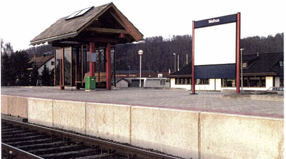
Foto 20: Idag er persontrafikken ved Melhus gamle stasjon nedlagt og flyttet til den nybygde holdeplassen Melhus Skysstasjon lenger sør i stasjonsbyen. Perrong, léskur og informasjonstavle er av høy standard, utviklet for "Trønderbanen".
