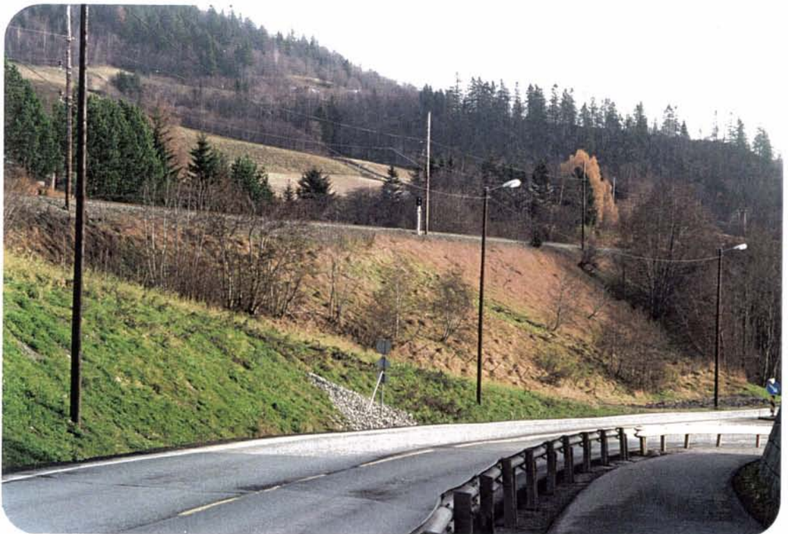
Foto 24: Idag er Kvålsviadukten erstattet av denne løsmassefyllingen.
