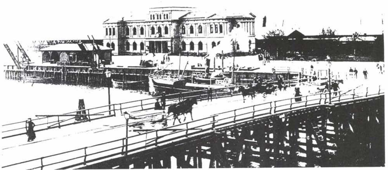
Foto 1: Stasjonsbygningen og stasjonsparken ved Trondheim i 1902. Bygningen er senere påbygd i høyden og vestover. Den siste rest av parkanlegget ble rasert høsten 1994, da den monumentale og frodige almelunden ble hugget i forbindelse med terminalutbyggingen(!)
