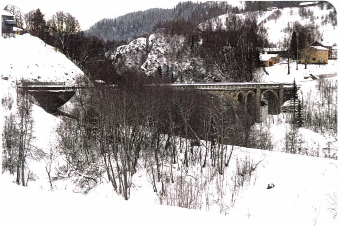
Foto 35. Vegbrua sør for Gaulfossen er av samme konstruksjon som jernbanebrua. Søndre tunnelportal for jernbanetunnelen er en del av konstruksjonen (t.v. på bildet).
