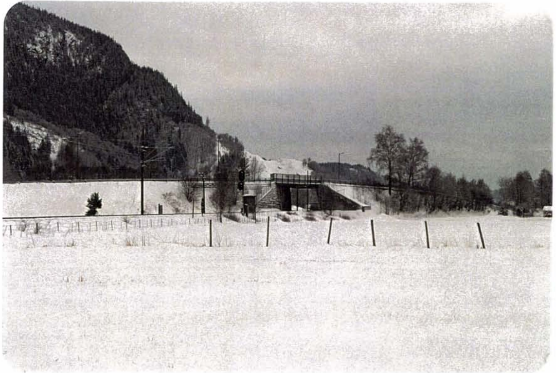
Foto 21: Overgangsbrua for E6 over jernbanen nord for Søberg er forankret i en mektig kunstig oppbygd terrengrygg i et ellers flatt jordbrukslandskap (gammel havflate). Idag ville en unngått slike løsninger.
