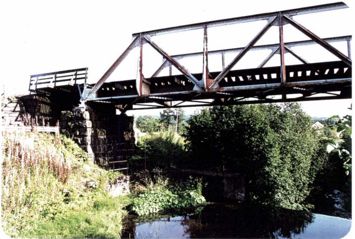
Foto 12: Brua over Leirelva ligger velplassert og nesten uforstyrret i landskapet. Brua er et 75 år gammelt teknisk kulturminne.
