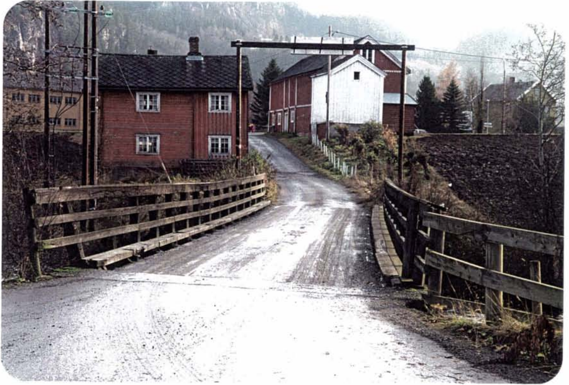
Foto 29 og 30: Det gamle industrimiljøet nord for Lundamo stasjon.
