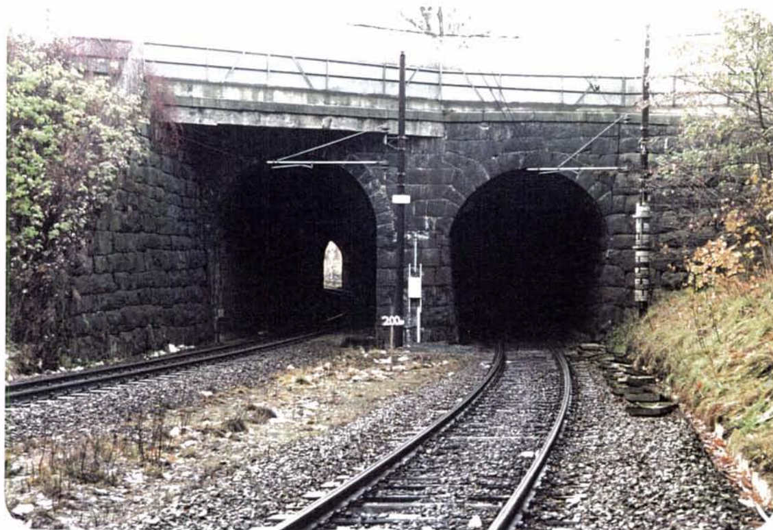
Foto 9: Tunnelene under Ilevollen (1884 og 1921) oppleves som en byport, og markerer de togreisendes ankomst til byen, havna og det åpne fjordlandskapet. Portalene er fint utført i murt stein.
