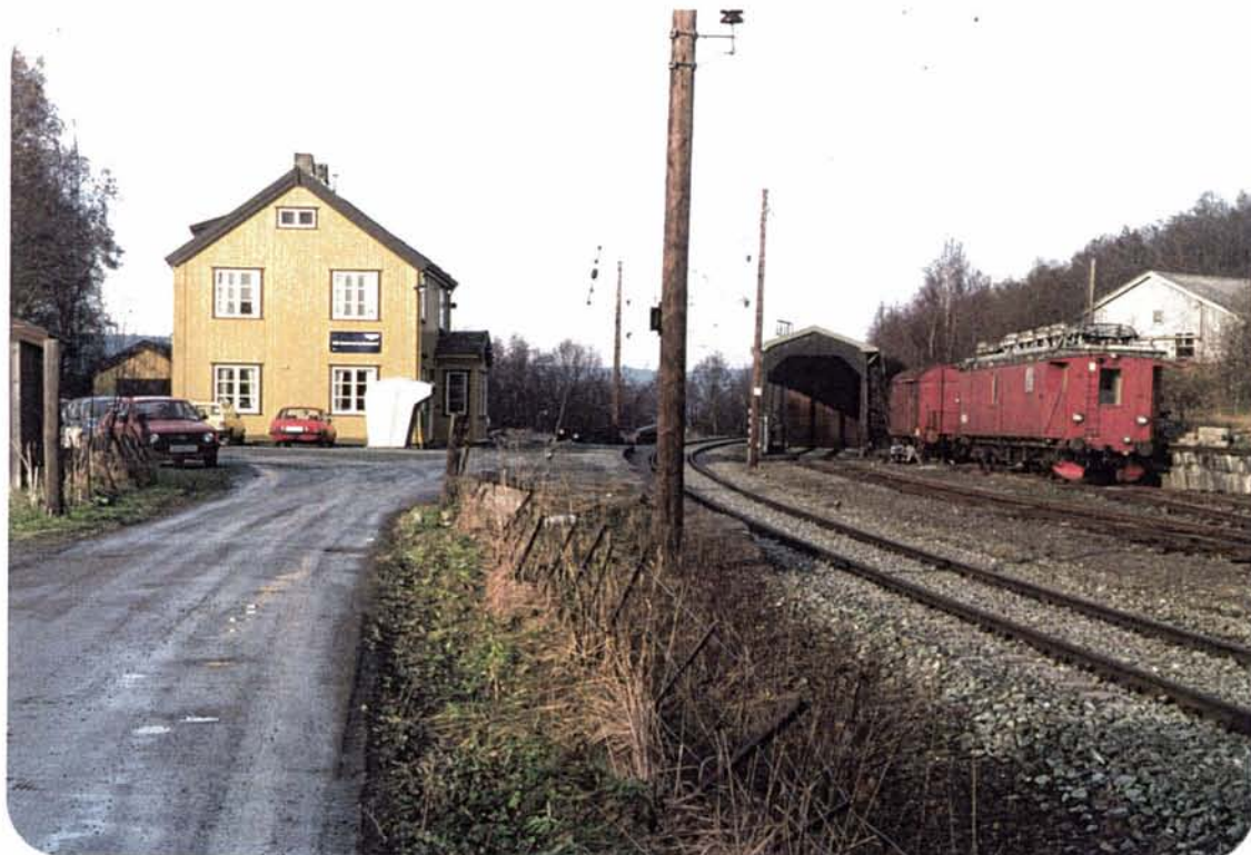
Foto 22: Stasjonsbygningen ved Kvål er fin og velholdt. Den ligger idag landskapsmessig og byplanmessig noe løsrevet fra tettstedet Kvål.
