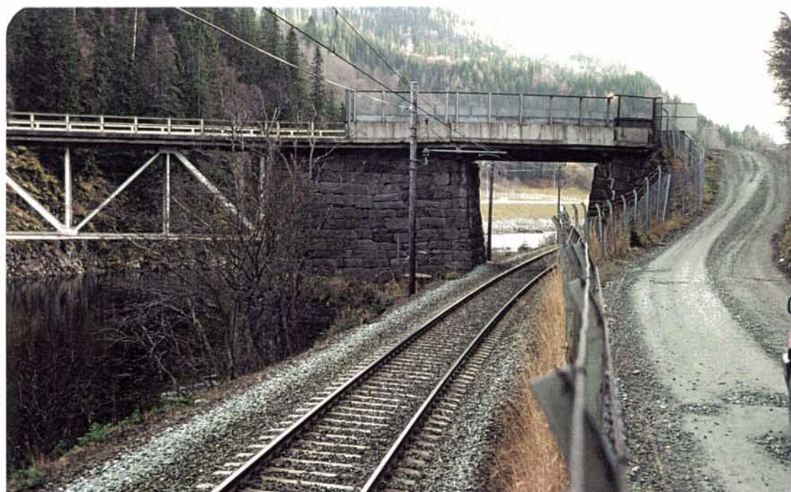
Foto 46: Hage vegbru ble bygget i 1898, og er et kjent landemerke for reisende med jernbanen. Over jernbanen går vegen på et lite spenn av stålbjelker. Samspillet mellom brua og den høge bergveggen på østsiden er spennende for de togreisende.
