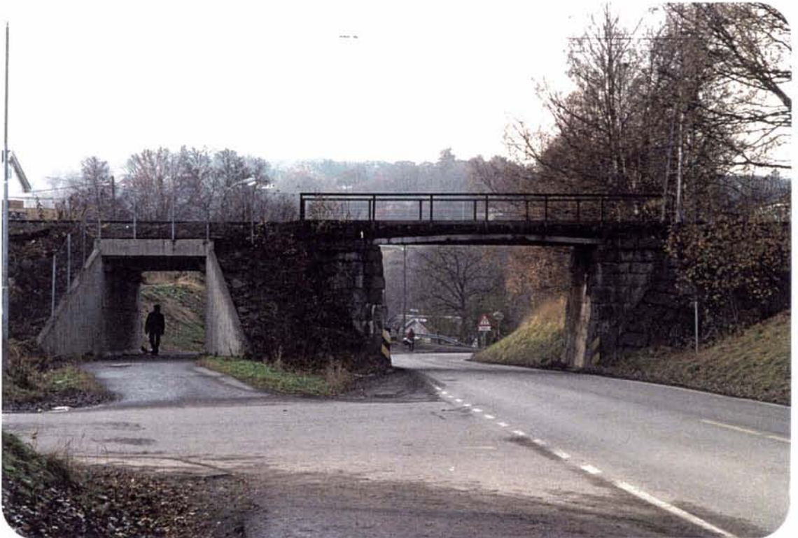
Foto 19: Høgbanen gjennom Melhus sentrum, med brua over riksveg 708. Bruspenet er ennå ikke erstattet av betongtrau med pukkballast, men kan stadig beundres i sin tilnærmet opprinnelige skikkelse. Gangkulverten til høyre med tilhørende flettverksgjerde, er av tvilsom arkitektonisk kvalitet, og står i sterk kontrast til brua over kjørevegen.
