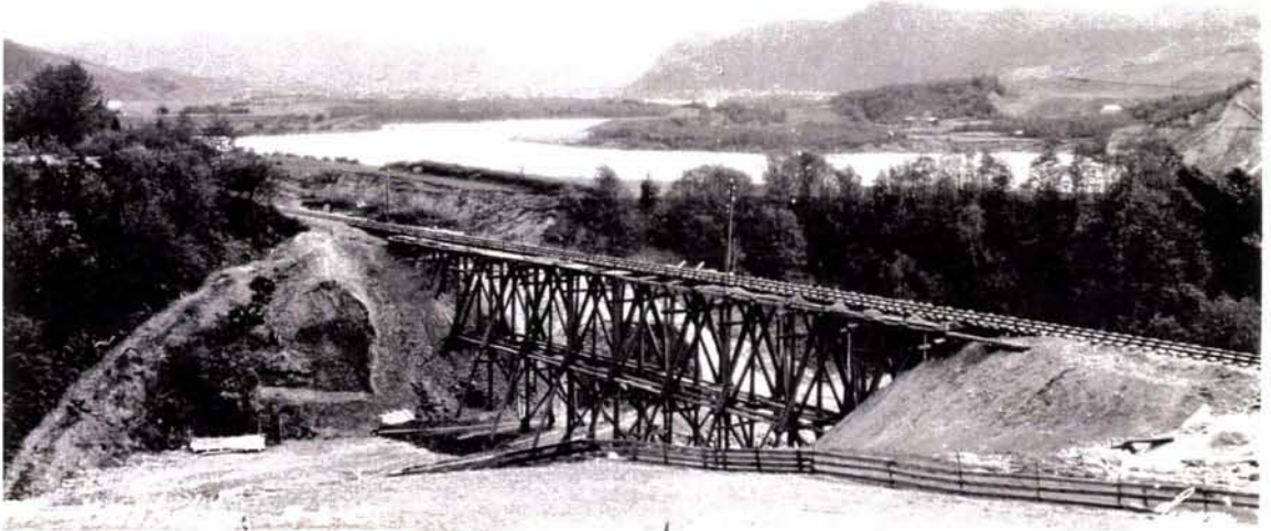
Foto 23: Da Dovrebanen ble anlagt, og Størenbanen fikk normal sporvidde, ble flere av de gamle treviaduktene erstattet med løsmassefyllinger. Treviadukten på bildet krysset Kvålsdalen like nord for Kvål stasjon. Foto fra 1915.
