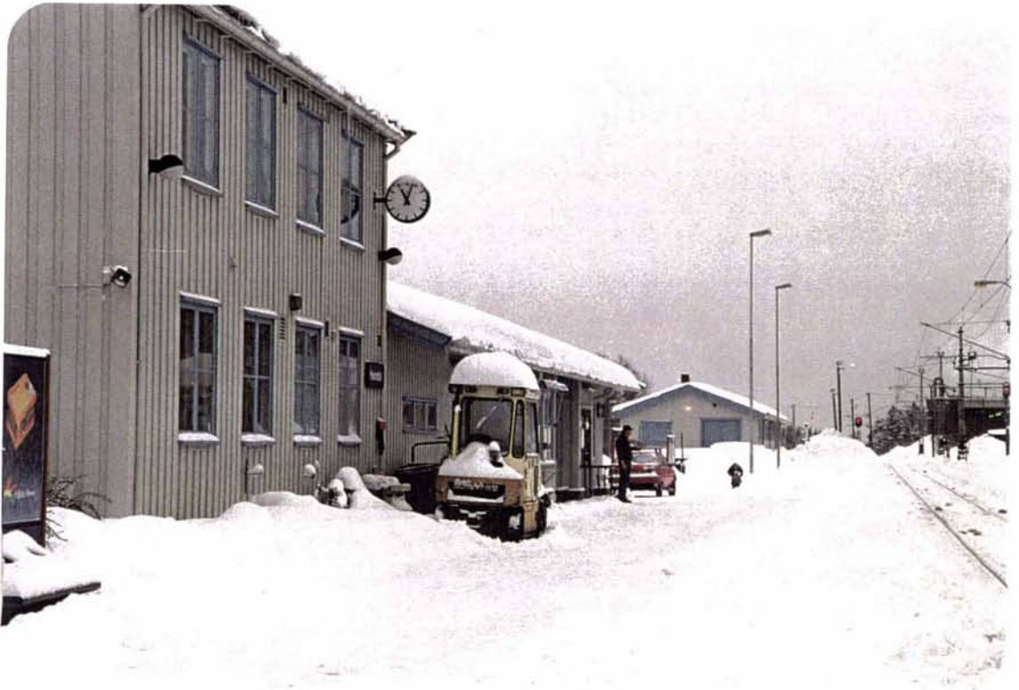
Foto 13: Heimdal stasjon. En noe varmere fargesetting ville gitt bygningene mer tyngde og økt kroppstemperaturen hos de reisende på kalde vinterdager. Området rundt stasjonen er nokså ødslig, men stasjonen ligger byplanmessig godt plassert i bygdesenteret, med korte avstander til forretninger og andre servicetilbud.
