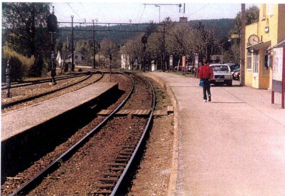
Figur 8 Plattform 1 og mellomplattform med planovergang sett i retning mot Oslo.
