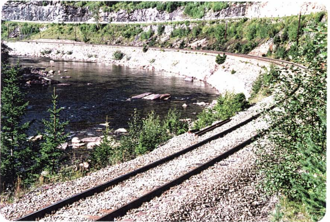
Foto 106: Rørosbanens krappeste kurve er "krokkurven" i Almåskroken. Kurveradius er kun 189 meter. Legg merke til den flotte steinplastringen i fyllingskråningen. Plastringen fungerer også som elveforbygning.
