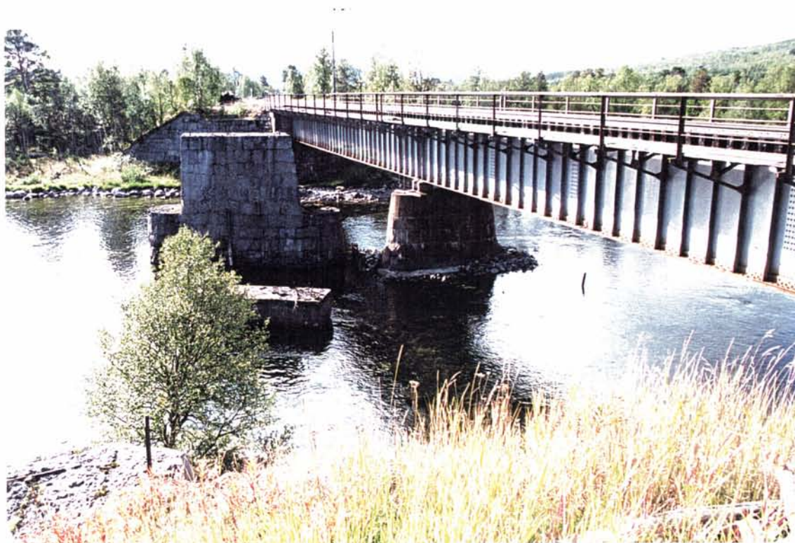
Foto 84 og 85. Jernbanebrua over Glomma ved Glåmos. Brua er ei 60 meter lang platebru i 2 spenn. Den ble bygget i 1949. Ved siden av brua sees karene til den gamle brua fra smalsportiden. Brua og stasjonsanlegget like nordenfor gjør at Glåmos idag oppleves som et sted med en sterk og levende kulturhistorie knyttet til jernbanen.
