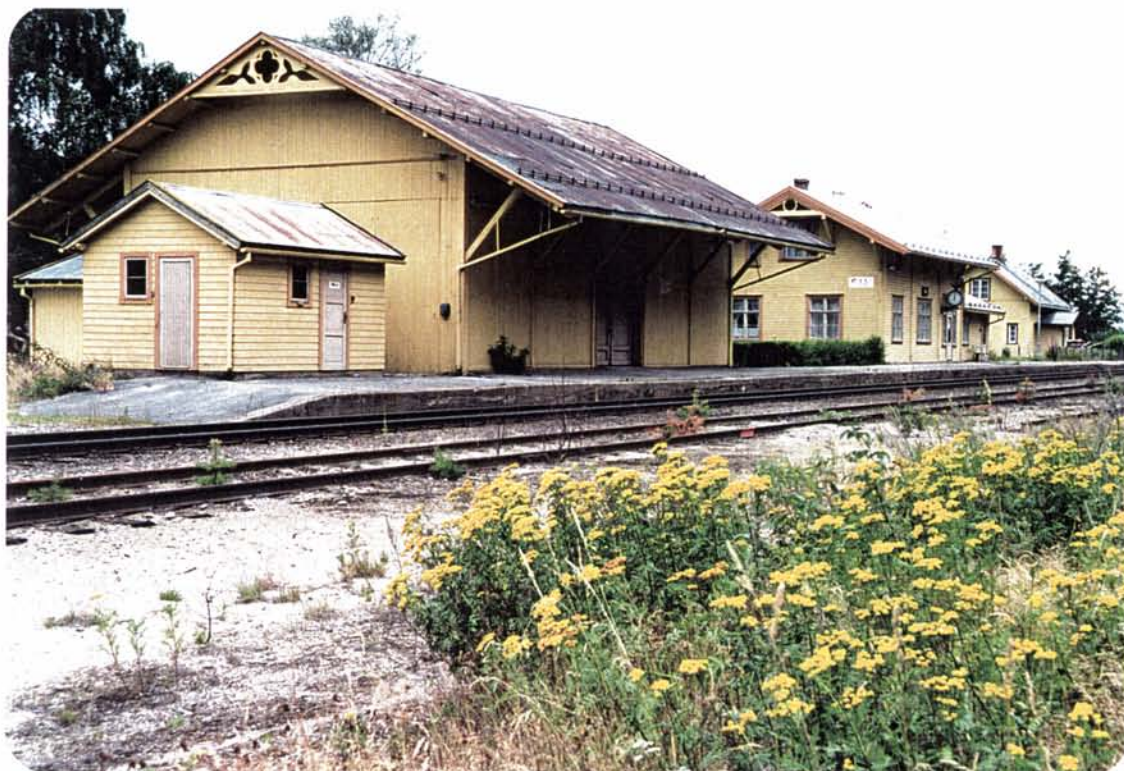
Foto 38: Stai stasjon er juvelen blant stasjonsmiljøene i Østerdalen. Stasjonsbygningen er tegnet av Georg Andreas Bull, og er eneste gjenværende representant for "Hvalstad-typen" langs Rørosbanen. Fra venstre sees privet, godshus, stasjonsbygning og vokterbolig.
