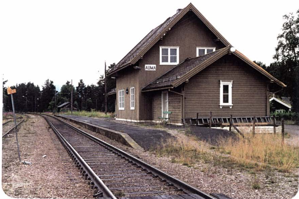
Foto 62: Stasjonsbygningen ved Auma (1877) står fortsatt som et minne fra jernbanens barndom i Glåmdalsføret.
