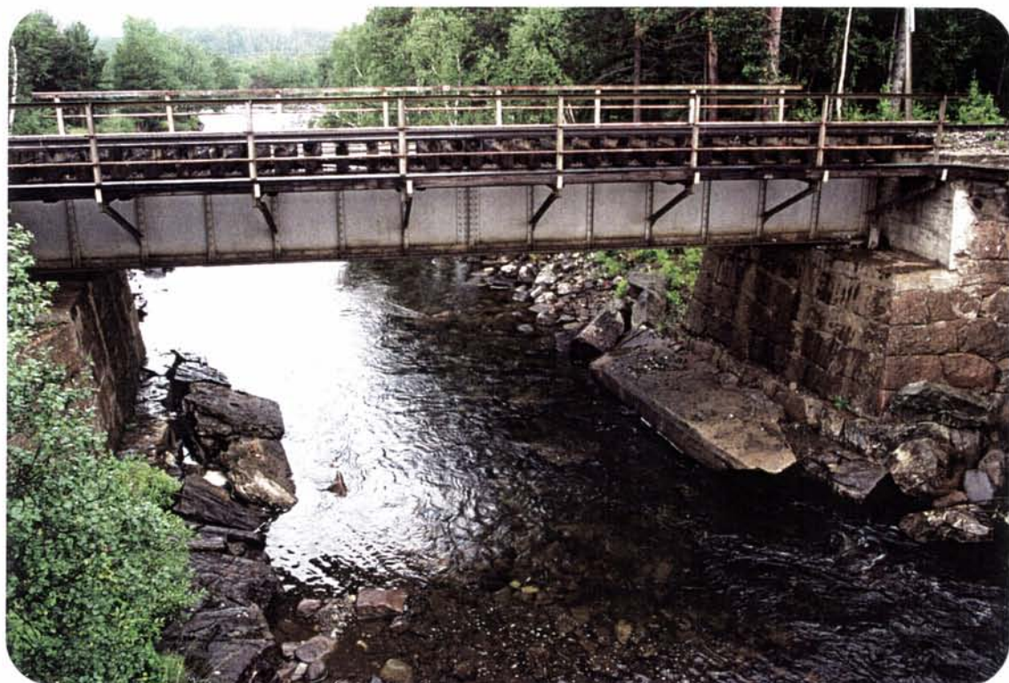
Foto 72: Platebrua over Høsa sør for Høsøien er representant for den vanligste brutypen langs Rørosbanen. Brutypen er brukt ved kryssing av mindre sideelver og bekker. Brutypen er enkel og tradisjonsrik.
