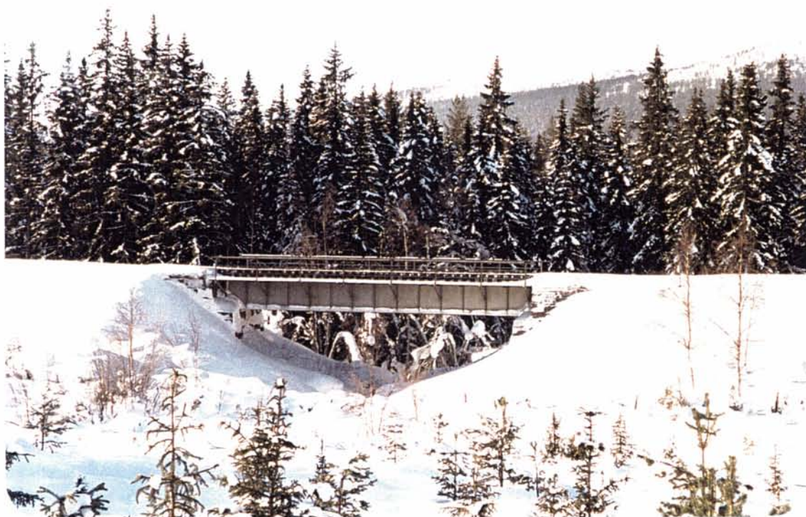
Foto 54: Typisk stålplatebru fra denne banestrekningen; klinkede platebærere som hviler på kar av naturstein.
