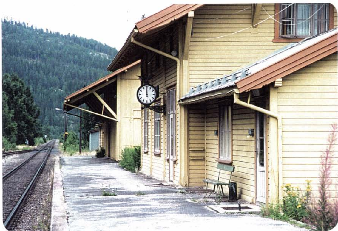
Foto 40: Bygningene ved Stai er har unngått ødeleggende moderniseringer, og er stadig i opprinnelig skikkelse, med store takutstikk som tjener som plattformoverbygg. Fargesettingen på husene er også meget god (se også rapportens forsidebilde).
