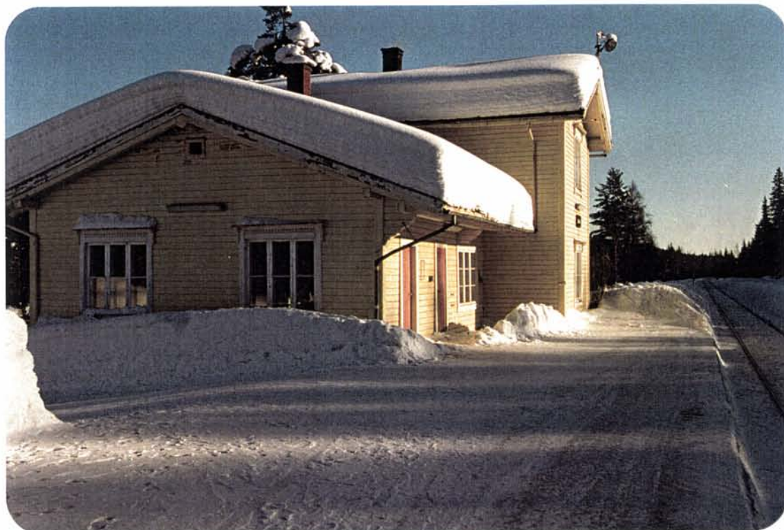
Foto 30: Stasjonsbygningen ved Steinvik er av type "Liten National", tegnet av Georg Andreas Bull. Samme type står også ved Steinsli.
