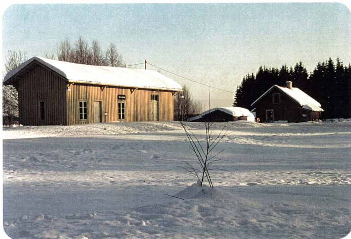
Foto 20: Ved Grundset ble godshuset fra 1862 innredet til stasjonsbygning da den opprinnelige stasjonsbygningen ble flyttet til Rena i 1871. Dette godshuset står ennå, og er en viktig markering av endepunktet for Norges første statbane.
