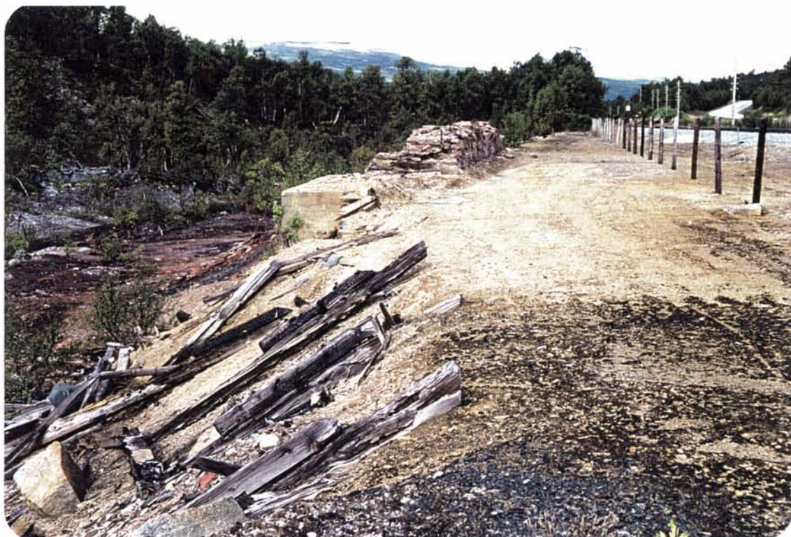
Foto 83: Ved Harborg sees ennå spor etter endestasjonen for taubanen fra Arvedals stoll.
