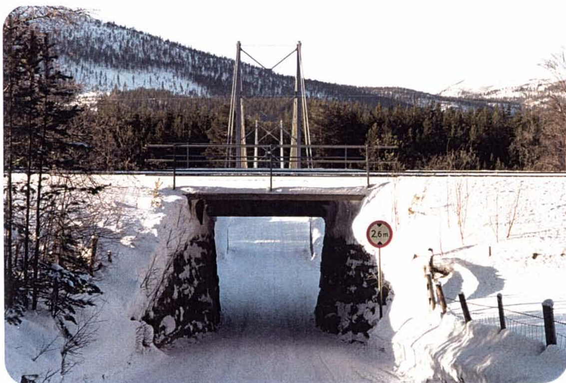
Foto 58: Fint samspill mellom jernbane og gammel landeveg ved Kveberg Bru. Hengebrua er fra 1930-tallet.
