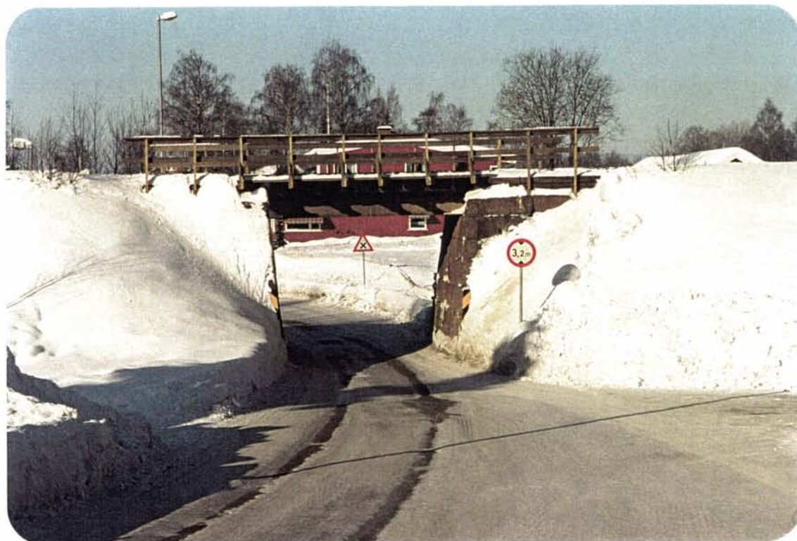
Foto 16: I Løten står fortsatt overgangsbrua over riksvegen i sin opprinnelige skikkelse, med stålbejler på murte kar av naturstein. Slike bruer er viktige kulturminner knyttet til jernbanen.
