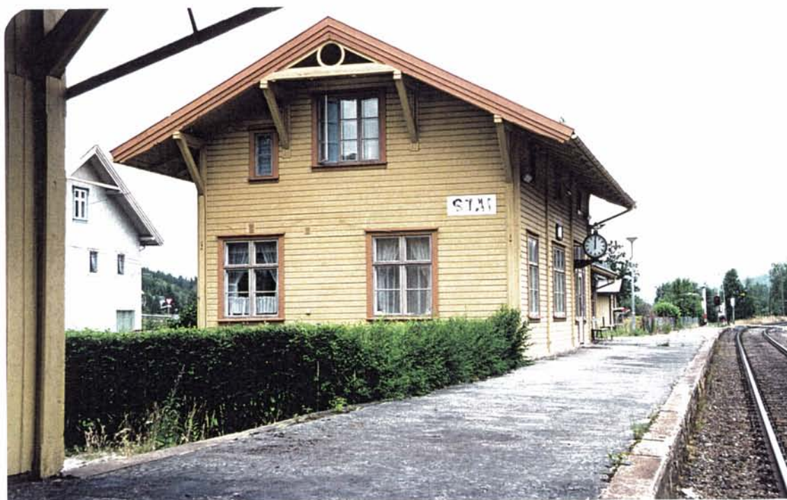
Foto 41: Stasjonsbygningen ved Stai (1873) er sammen med godshuset (1874) og vokterboligen (1898) oppført på verneplanen. Til venstre for stasjonsbygningen sees den nå nedlagte landhandelen.
