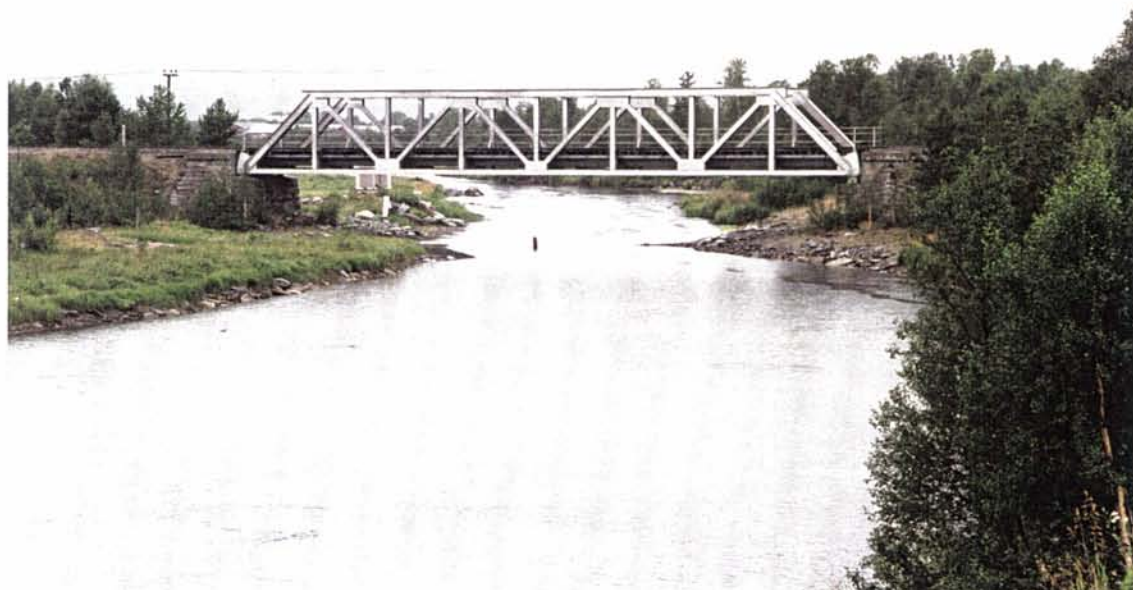
Foto 73: Lengre bruer, som den 36 meter lange brua over Håelva, ble gjerne bygd i stålfagverk. Brua ble bygd i 1942 i forbindelse med linjeomleggingen ved Røros. Brutypene ovenfor er forlengst gått ut av bruk ved NSB. Kanskje de får sin renessanse i fremtiden?
