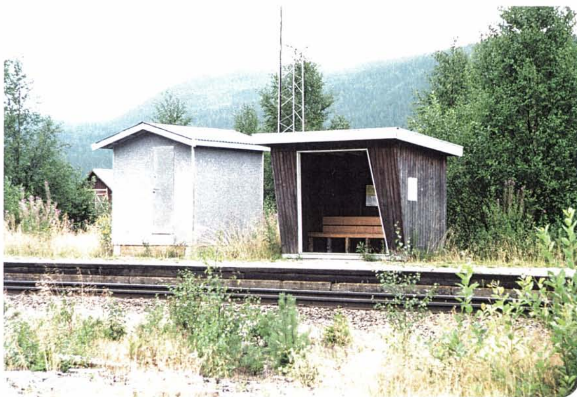
Foto 37: Ved Evenstad er stasjonen forlengst revet og erstattet med dette léskuret. Skuret er ærlig nok, men knuges av elementene i det nye sikringsanlegget bakenfor.
