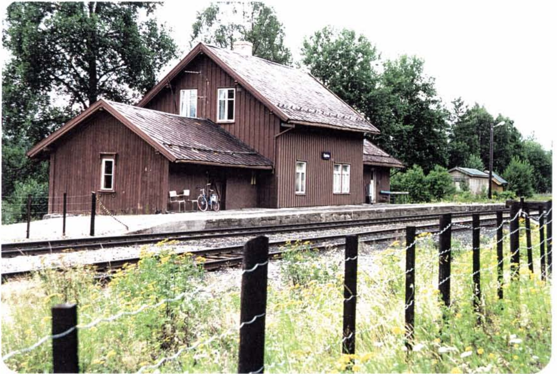
Foto 33: Den opprinnelige stasjonsbygningen ved Opphus står ennå. Bygningen ble tegnet av Peter Andreas Blix og er av "Opphus-typen", en stasjonsbygning med sammenbygd godshus for mindre stasjoner. Typen er også representert ved Barkald og Auma.
