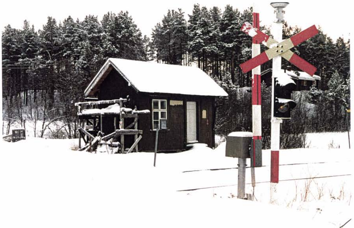
Foto 68: Hummelvoll (Håmålvoll) holdeplass nord for Tolga ble opprettet i 1916 og hadde persontrafikk til nedleggelsen i 1987. Ekspedisjonsbygningen fra 1918 står fortsatt, og blir nå rehabilitert av lokale krefter. Bygningen står på NSB's verneplan.
