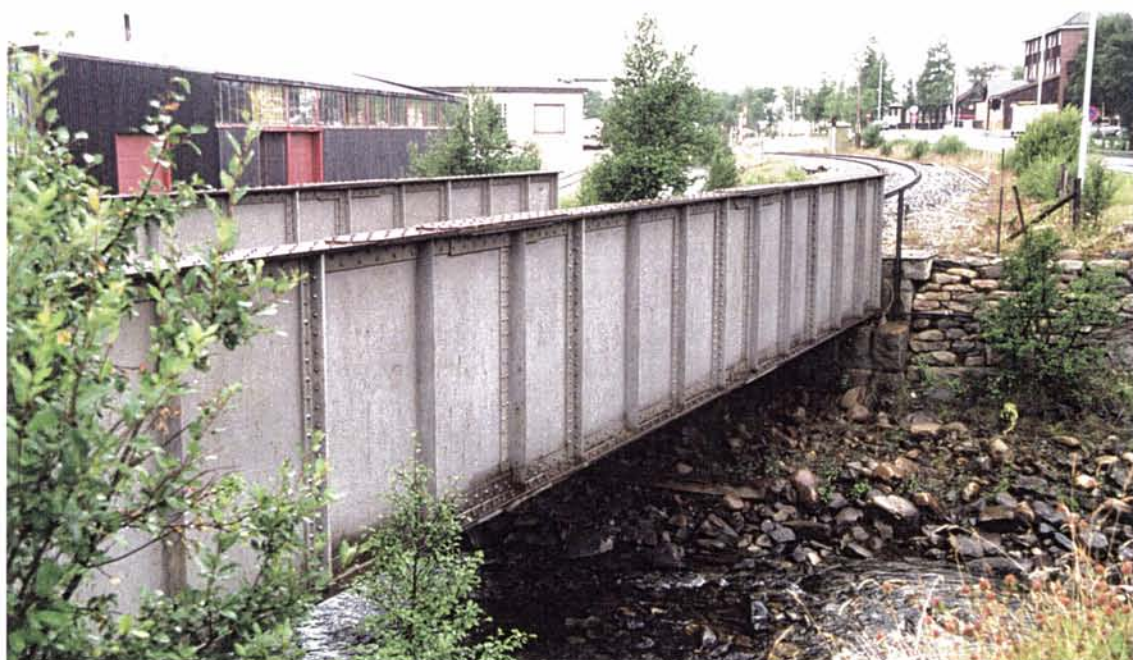
Foto 77: Jernbanebrua over Hitterelva (1944) har et 20 meter spenn av klinkede platebærere. Den skiller seg fra de øvrige platebruene langs banen ved at bæringen er lagt over banelegemet. Dette har nok sammenheng med trangt elveprofil og fare for isoppstuvning.
