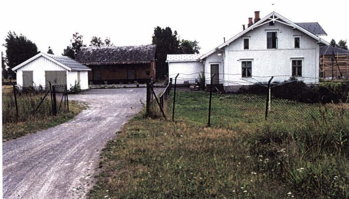
Foto 9: Ilseng stasjon ligger nokså ensomt utenfor tettstedet. Stasjonen er i god tilstand, og har verdi som kulturminne fra den gang stasjonen var betydningsfull og toget var det viktigste kommunikasjonsmidlet. Bakerst i bildet sees det gamle godshuset.
