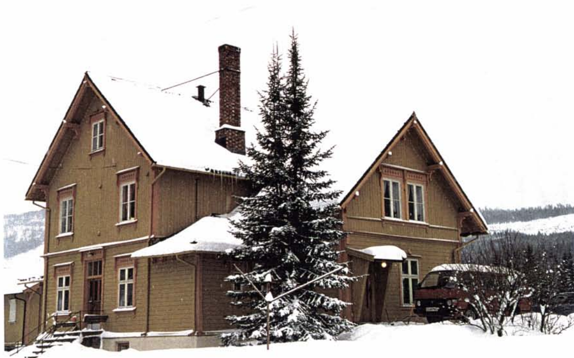
Foto 108: Den prektige stasjonsbygningen ved Singsås sett østfra. Hageanlegget ligger til høyre. Bygningen er av type "Mellemstation 1ste Klasse", tegnet av Peter Andreas Blix, og fins også ved Tynset og Alvdal.
