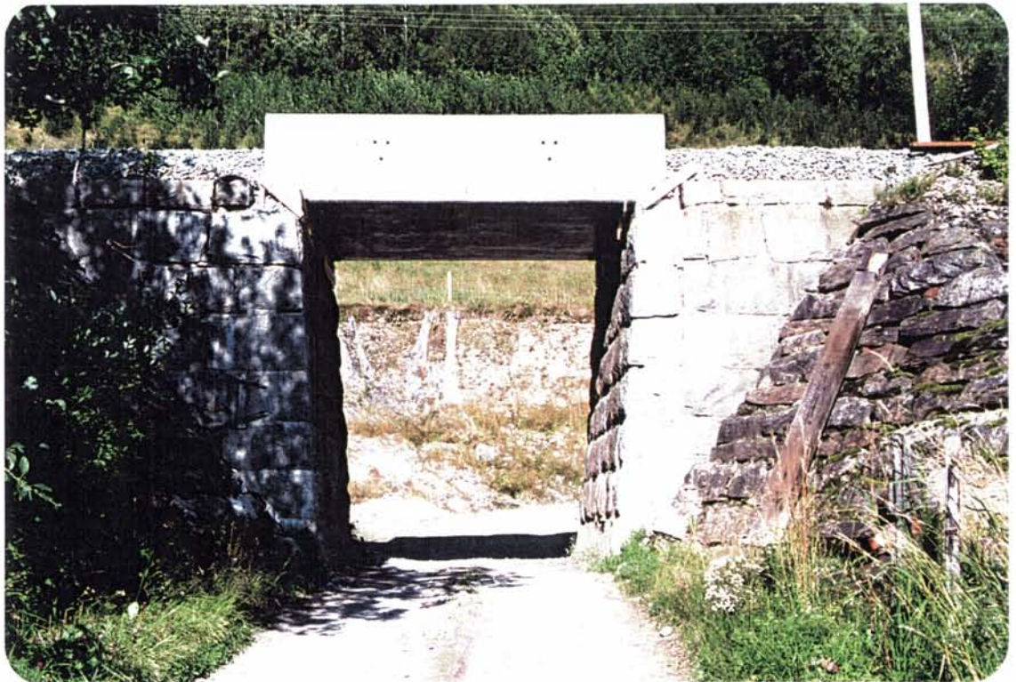
Foto 102–103: Disse undergangene ved Gåre illustrerer at ombygging av eldre underganger fra stålbeltekonstruksjoner til trau med pukkballast kan være problematisk estetisk sett. Disse løsningene gir ikke et godt visuelt svar på oppgaven.
