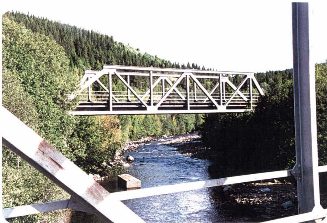
Foto 100: Fagverksbrua over Holta ved Gåre (31 meter lang) er den eneste "klassiske" fagverksbrua i Gauldalen sør for Støren. Den hviler på fint murte landkar av naturstein.
