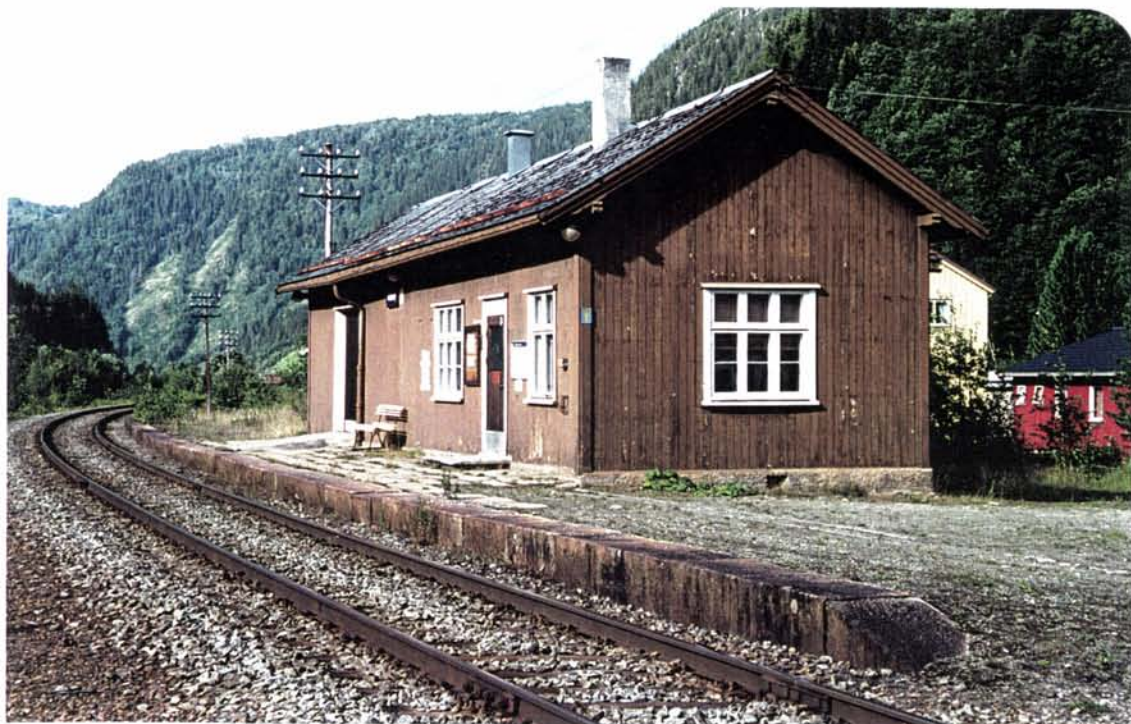
Foto 112: Ekspedisjonsbygningen ved Kotsøy (1892) er et interessant kulturminne som dessverre er foreslått revet. Det er å håpe at lokale krefter kan bevare og vedlikeholde bygningen som et samferdselshistorisk kulturminne.
