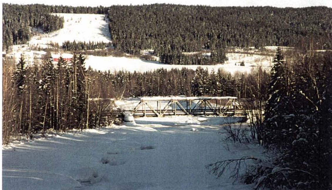
Foto 23: Brua over Åsta er en tradisjonell fagverksbru i to spenn på steinpillarer. Med en lengde på 66 meter i 2 spenn er dette den nest lengste jernbanebrua i Østerdalen. På bildet sees et typisk landskapsprofil på denne strekningen: Granskog i liene og dyrket mark og mindre skogteiger nede i dalbunnen.
