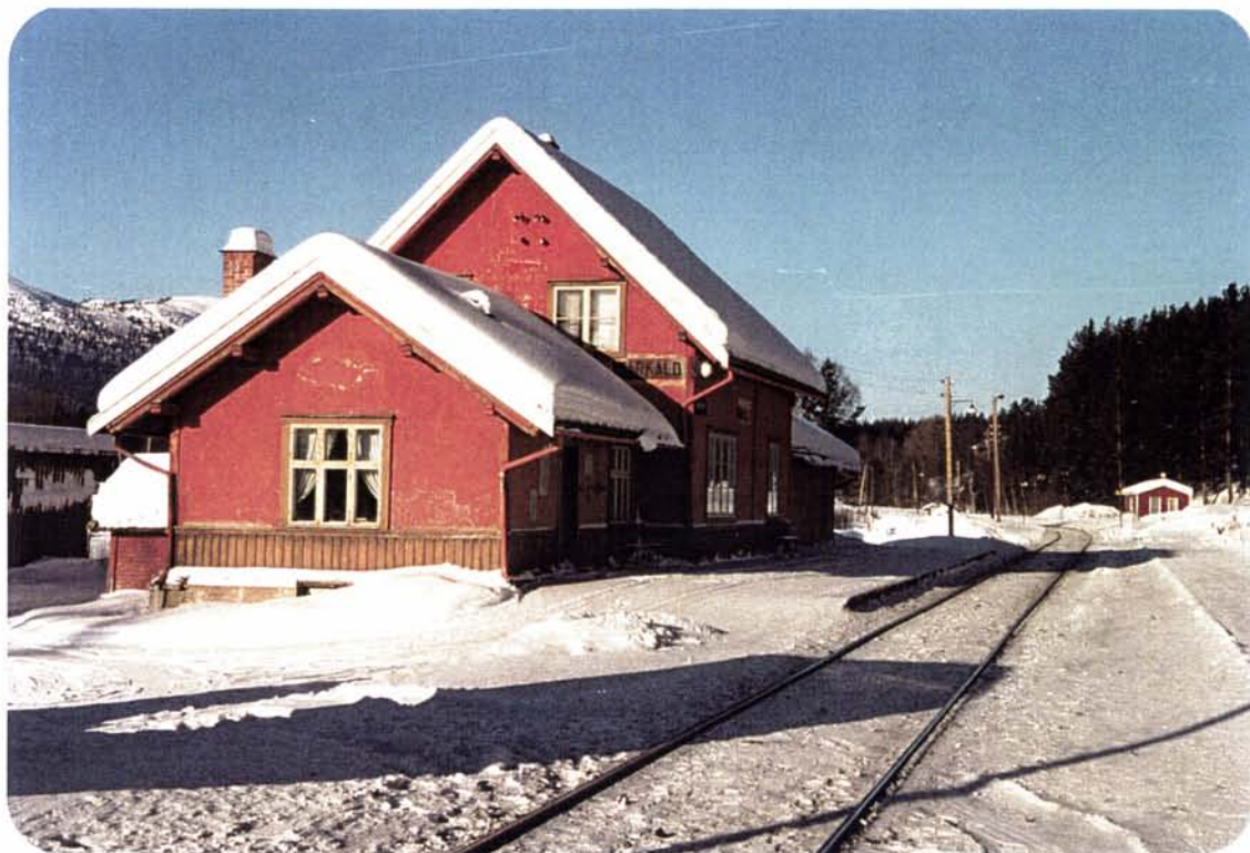
Foto 55 og 56: Barkald ligger i idylliske omgivelser ved Glomma. Stasjonsbygningen er av Peter A. Blix' "Opphus-type", som også fins ved Opphus og Auma. Merk at tømmeret er rappet med murpuss. Stasjonen ligger idag ensomt til. Dersom stasjonsbygningen blir revet, vil også stedet og den levende historien forsvinne.
