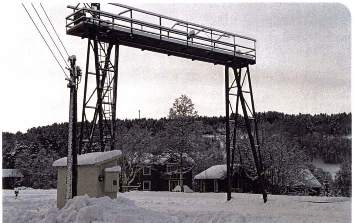
Foto 67: Enkle portalkraner av denne type finner vi ved flere stasjoner langs Rørosbanen. De er tekniske kulturminner, og viktige elementer i et stasjonsmiljø. Det er å håpe at noen får lov å stå som kulturminner, selv om de etter hvert er tatt ut av bruk.
