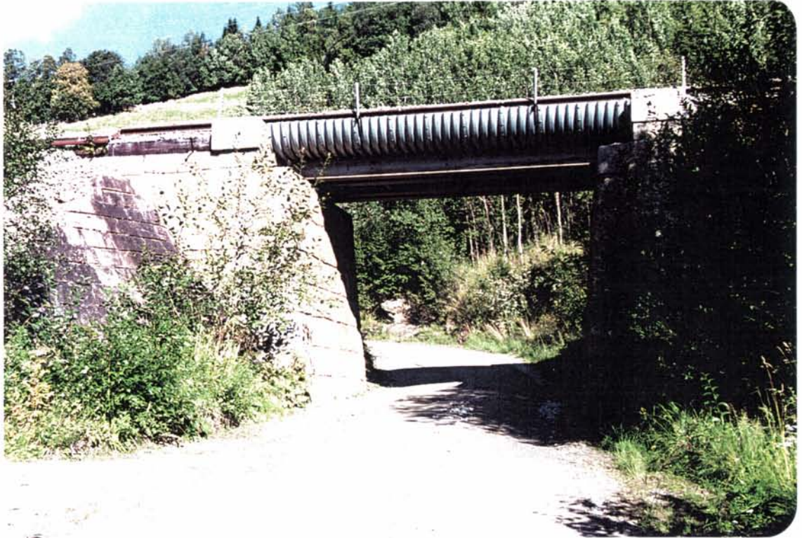
Foto 102–103: Disse undergangene ved Gåre illustrerer at ombygging av eldre underganger fra stålbeltekonstruksjoner til trau med pukkballast kan være problematisk estetisk sett. Disse løsningene gir ikke et godt visuelt svar på oppgaven.
