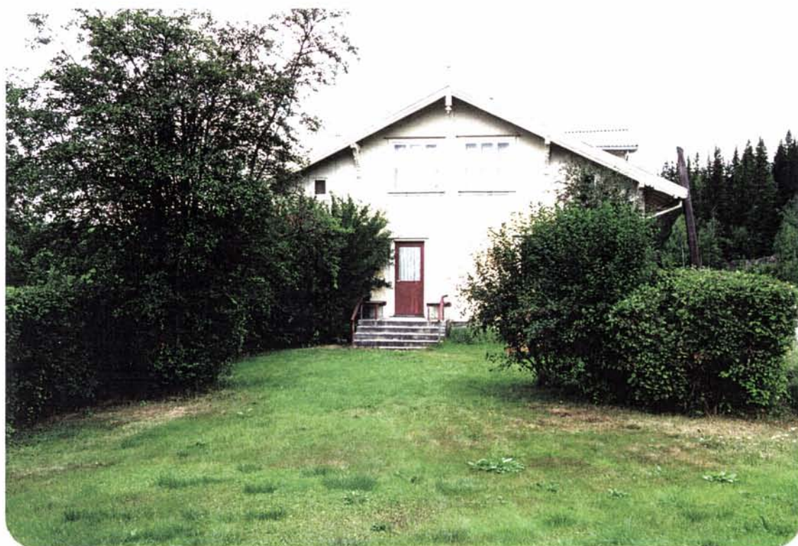
Foto 36: Vokterboligen ved Rasta (1873) er bygd i plank og rappet med murpuss. Den ligger i god kontakt med den gamle stasjonshagen, som stadig holdes i hevd. Bygningen står på NSB's bevaringsplan.
