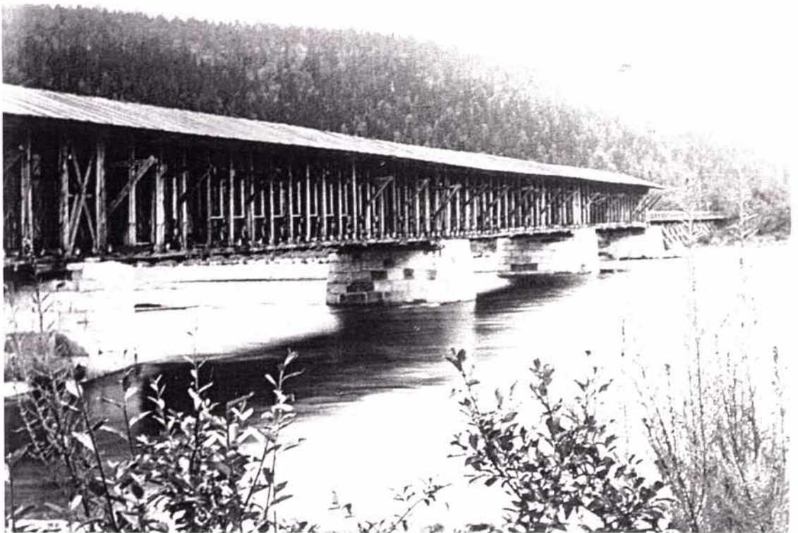
Foto 117: Støren jernbanebru på 1940-tallet. Brua ble midlertidig forsterket til omleggingen til normalspor i 1941, og fikk da denne uvanlige takkonstruksjonen. Brua ble avløst av ny stålbru i 1951.
