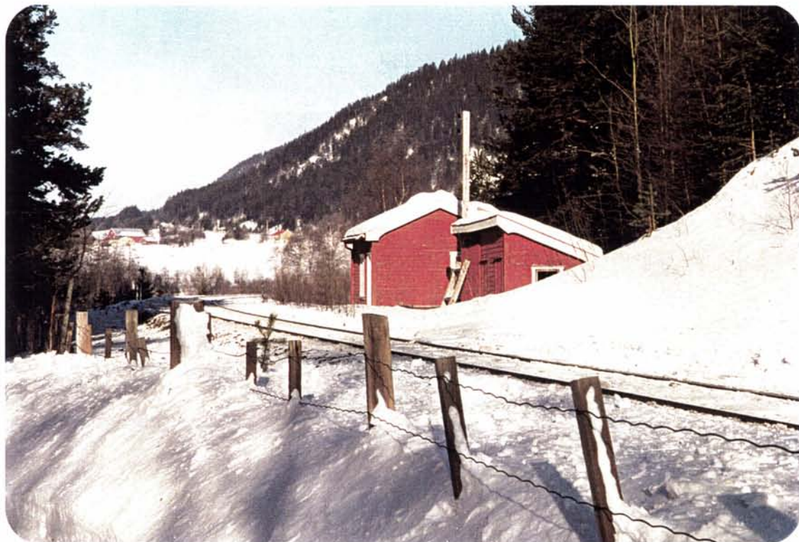
Foto 57: Gjerdene og baneavdelingens bygninger er også elementer i et levende jernbanemiljø. Foto ved Kveberg.
