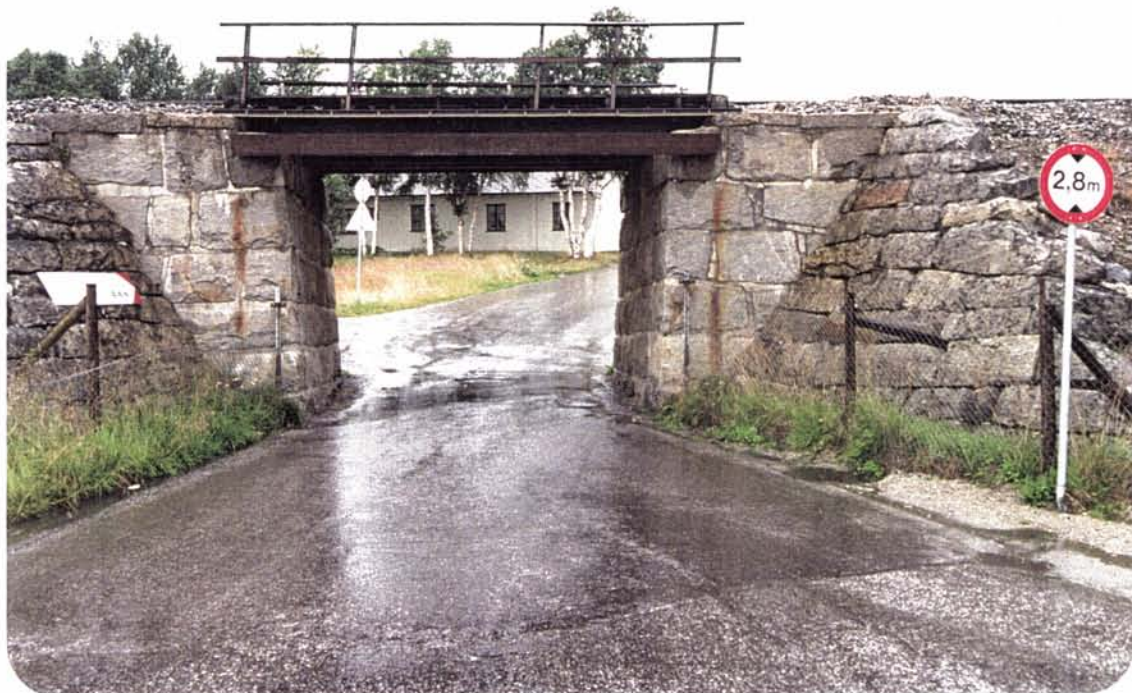
Foto 75: Undergangskulvert gjennom høgbanen sør for Røros stasjon. Legg merke til de fine murarbeidene.
