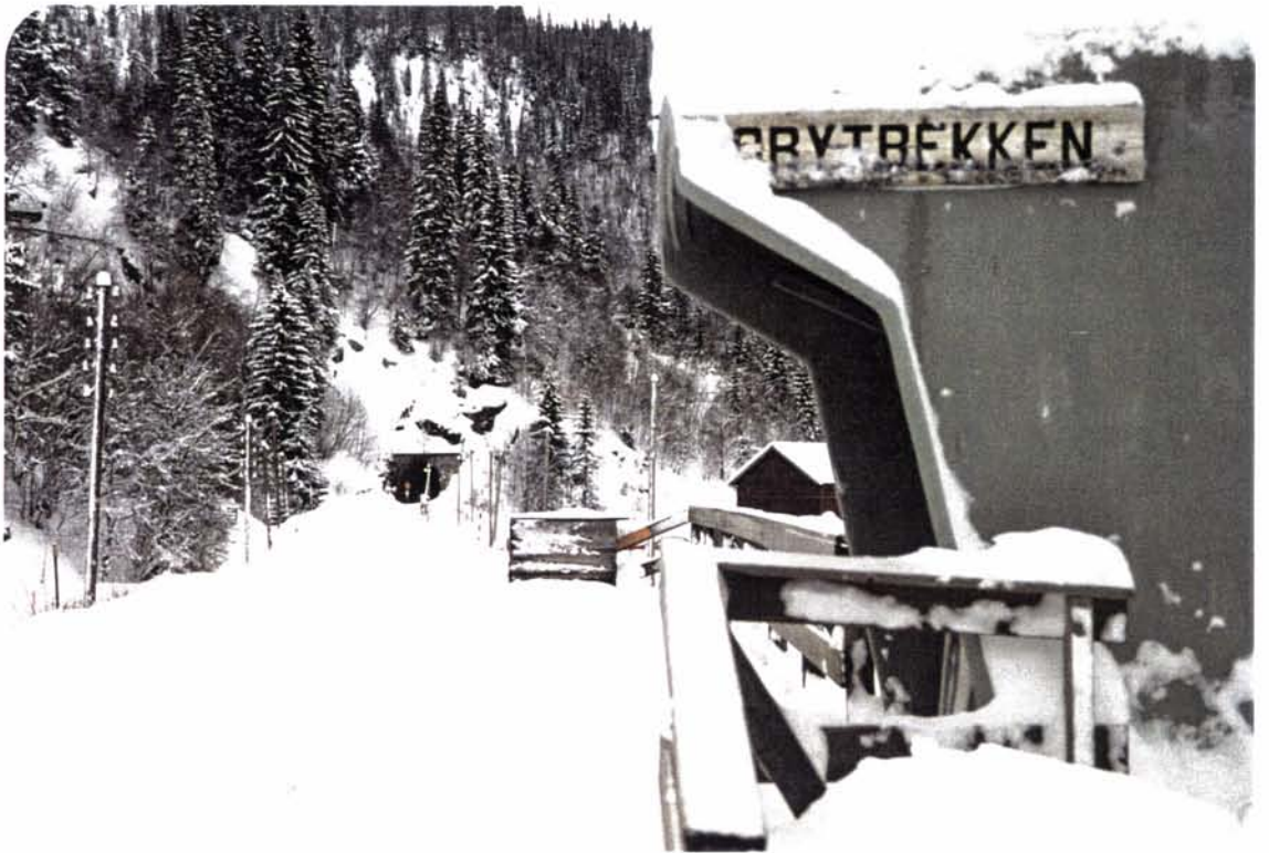
Foto 116: Grytbekken holdeplass med den fine steinportalen på Røttum tunnel i bakgrunnen.
