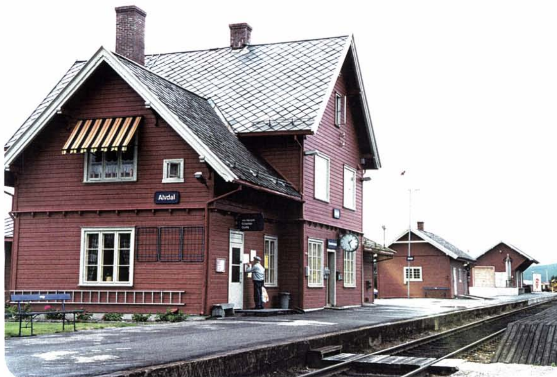
Foto 60: Alvdal stasjon har et interessant og velholdt bygningsmiljø fra jernbanens åpning i 1877. Stasjonen ligger sentralt i bygdesenteret.
