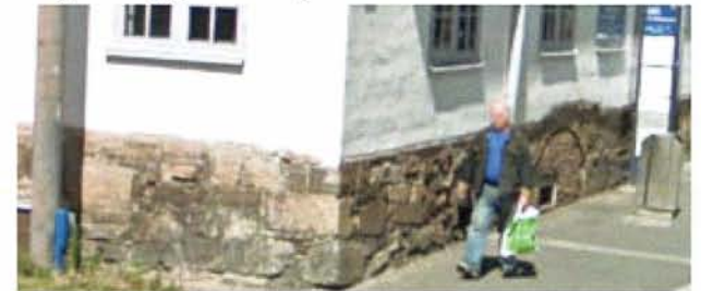
Grunnmur i naturstein i Oslo Ladegård
