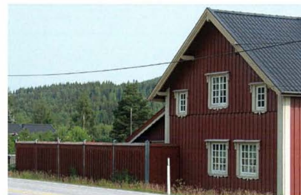
Eksempel på lokale støyskjermer knyttet til lokalmiljøet. Langs riksvegen til Kongsvinger ved Skarnes.
