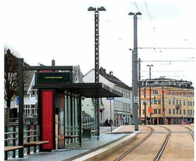
Spesialdesignede bjelkemaster langs Bybane i Bergen
