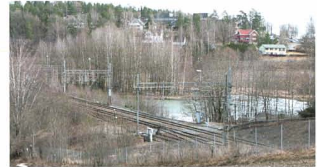
Kapelldammen inntil dagens Østfoldbane
