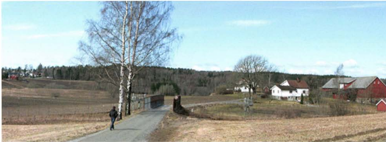
Eksisterende bru over jernbanen ved Endsjø gård – en kort og smal bru til gårdsbruket
