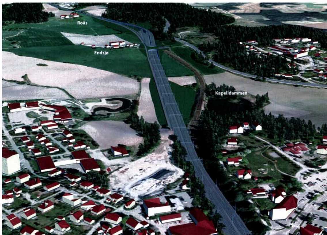
Figur 81 Oversiktsbilde over dagstrekning nord for Ski.
