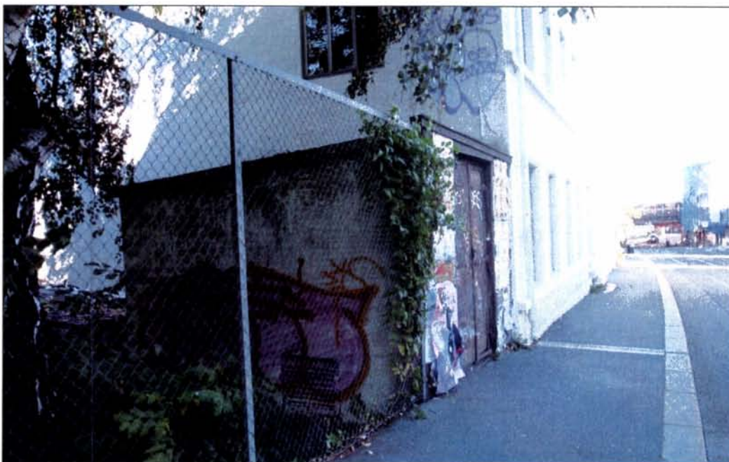
Dagens situasjon mot Oslo gate. I dette området viser skissen på foregående side en forplass.
