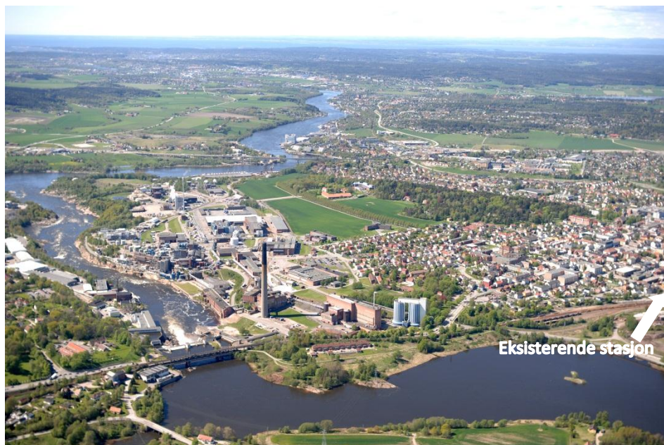
Figur 33: Sarpsborg sett fra nord.
