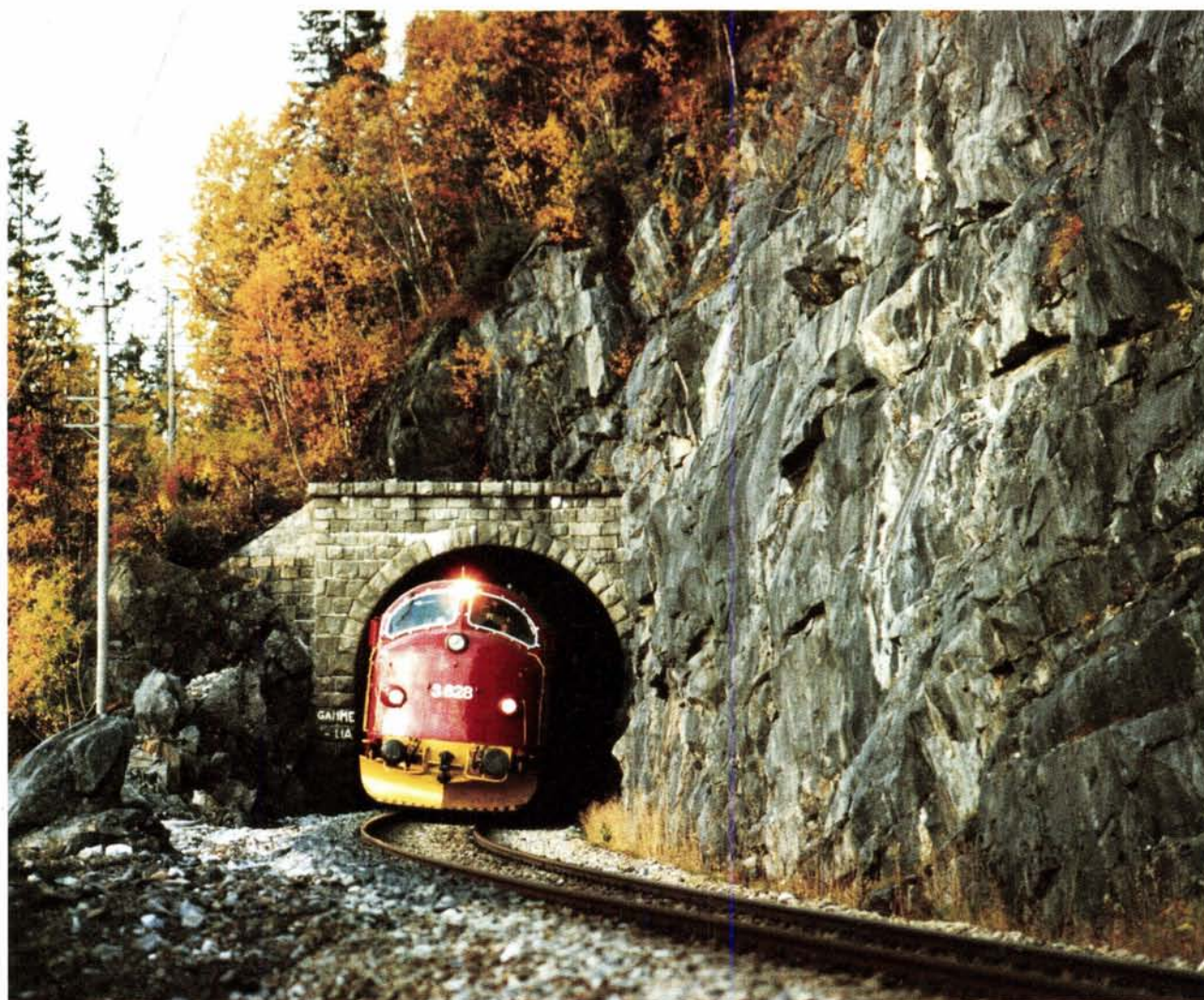
Figur 1.5 Utvidelse av tunnelverrsnitt og fjellskjæringer er nødvendig før elektrifisering.
