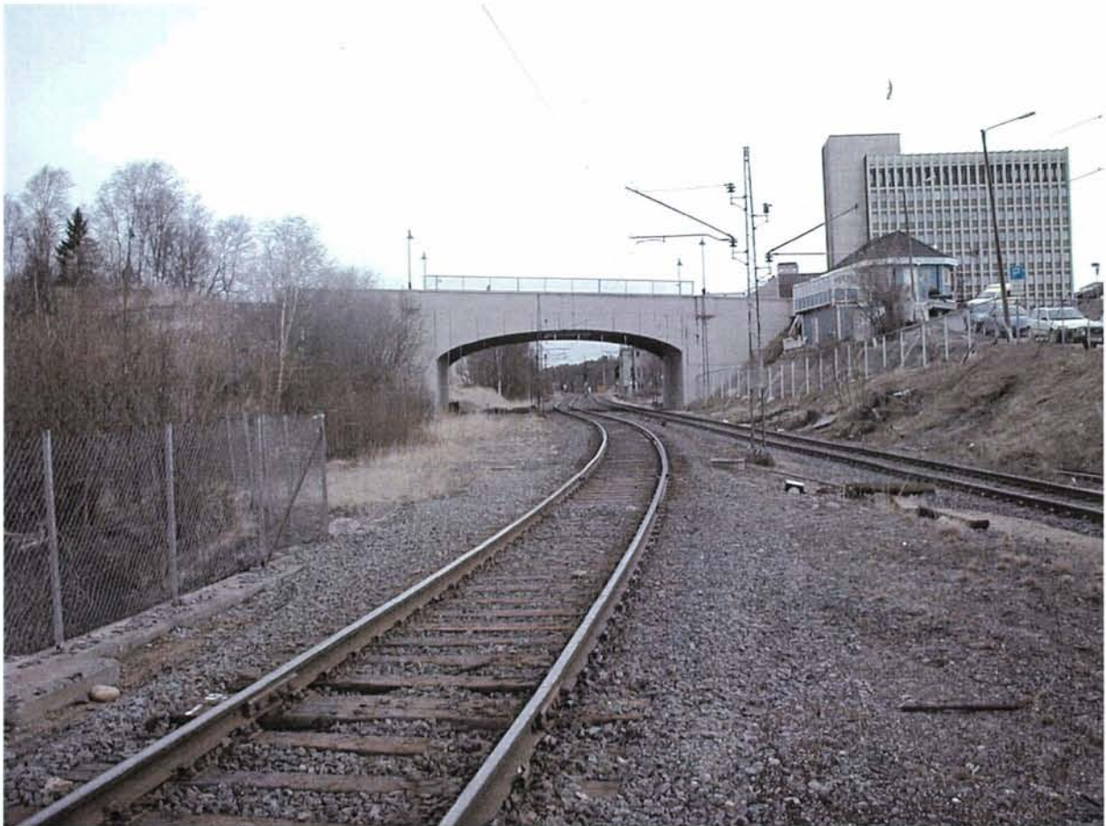
Figur 1: Brugata med Fagernessporet til høyre og DEMAG-sporet til venstre.
